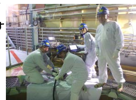
ケーブル劣化診断法適用性試験状況
