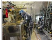
残留重水回収作業の状況
