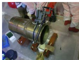
ゲージ貼付け、切断状況
