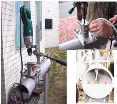
配管内残留液体の回収治具の試作・製作
