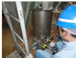
遮へい冷却水抽出し作業状況
