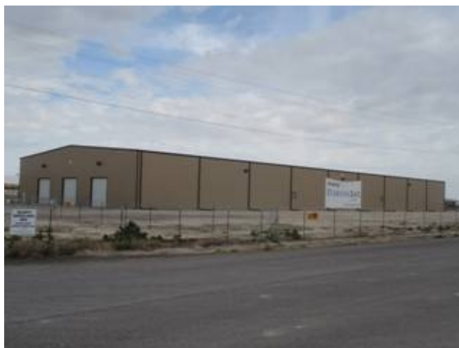
図 5.5.1 クライブに立地する劣化ウラン貯蔵庫 (Energy Solutions 社提供)
