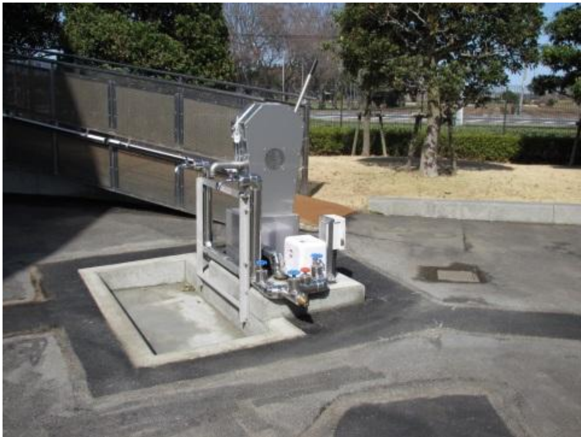
写真 7.1-3 取水用井戸の設置（平成 25 年 3 月設置）
