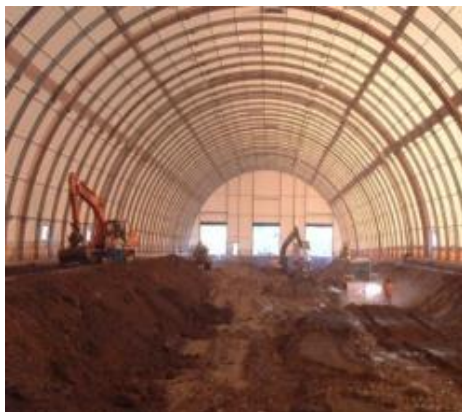
図 3.1-4 トレンチの掘削 (ANDRA 提供)
