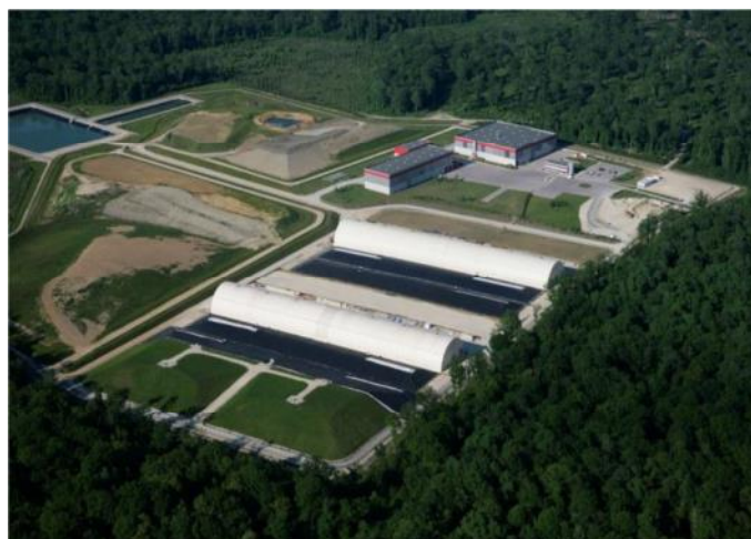
図 3.1-2 モルヴィリエ処分場の全景
