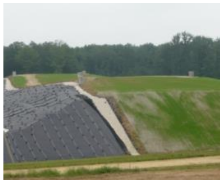
図 3.1-10 上部遮水シート設置、覆土 (ANDRA 提供)
