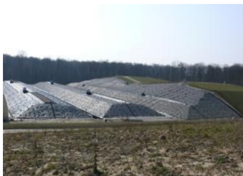
図 3.1-9 埋戻し及び上部遮水シート施工 (ANDRA 提供)
