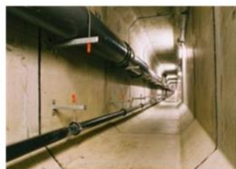
地下の集水坑
