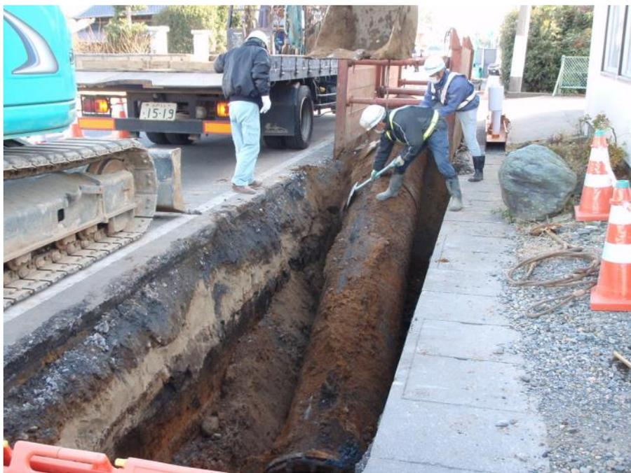
写真 2.11.4 導水管撤去状況（白方地区原研道路）
