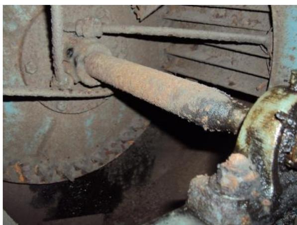
写真 2.1.13-1 EXF-4 ファン羽根の脱落状況
