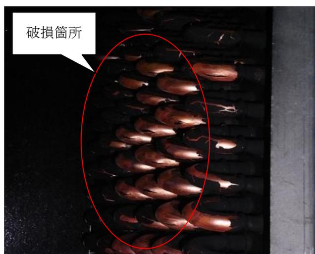
写真 2.1.10-1 破損した AC4 系統の冷水コイル
