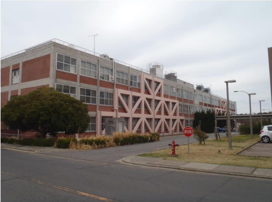
写真 2. 11. 2-1 第1 研究棟耐震補強
