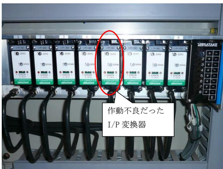
写真 2.1.7-1 排気第14-2系統用 I/P 変換器
