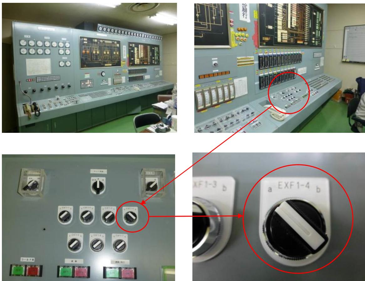
写真 2.1.14-1 工務監視盤及び先行切替スイッチ
