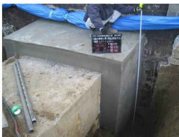
写真 2.8.5-3 コンクリートダクト補修後
