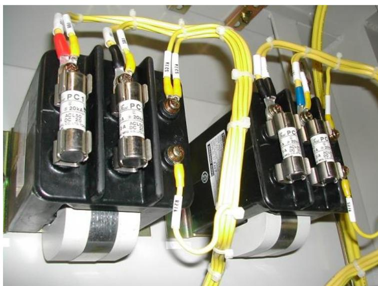
写真 2.8.4-1 計器用変圧器
