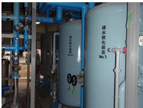
写真 2.11.3-2 硬水軟化装置更新後
