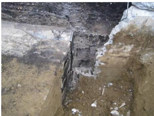
写真 2.8.5-2 コンクリートダクト補修前
