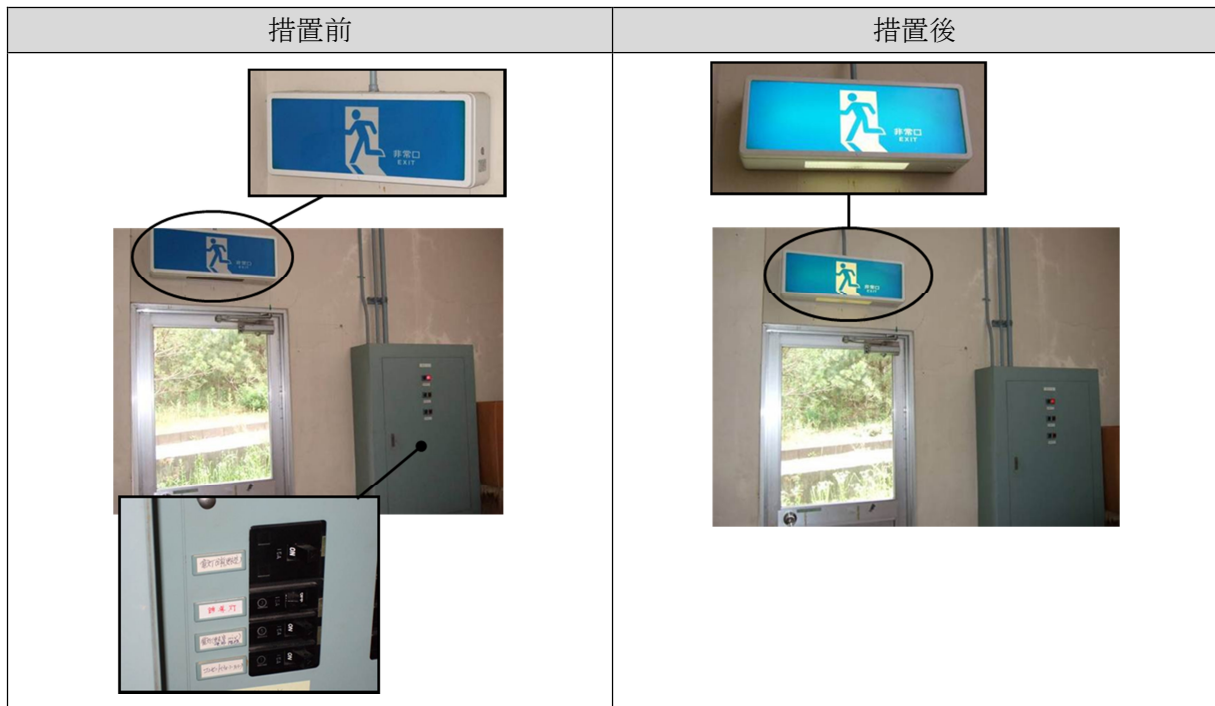
Photo. 12-5 建家誘導灯の絶縁不良
