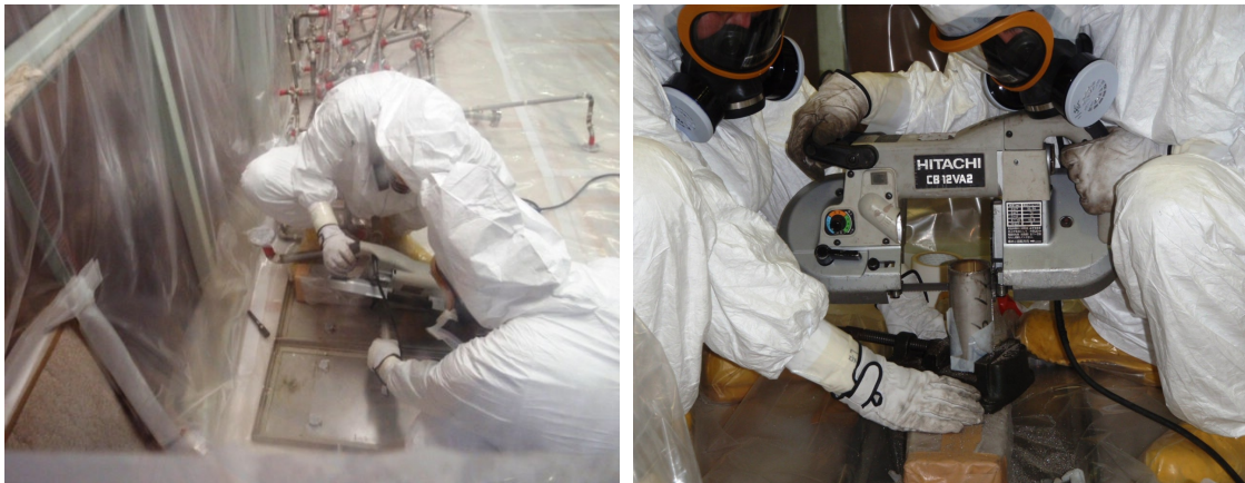
図 3.8 作業風景（簡易ハウス内）
