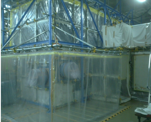
解体撤去用 GH, コンテナハウス
