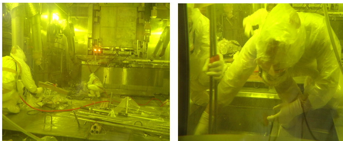
図 3.3 作業風景 (R335 内)
