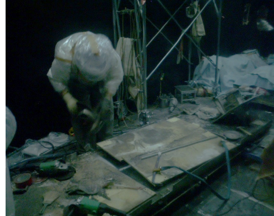
解体撤去状況
