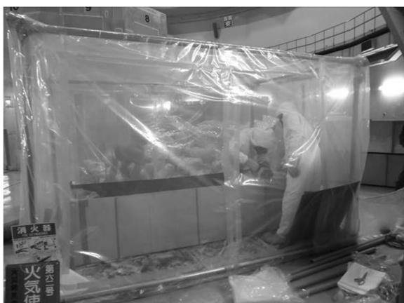
炉室内での排気ダクトの細断作業
