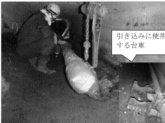
切断した廃液輸送管の引き込み
