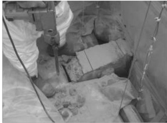
コンクリートキャッチの取り外し作業
