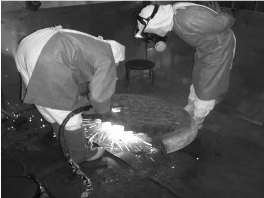
図 4.4.2-1 プラズマ切断機による切断状況
