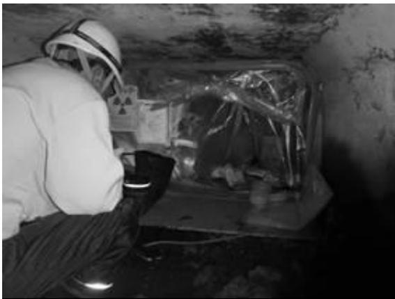
第2排水溝内部でビニールハウスの設置
