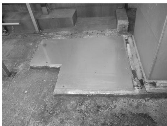
排気ダクト撤去後の開口部の閉止措置
