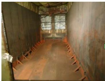
解体撤去前のB復水器内部
