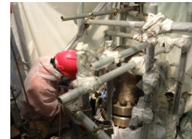
プーリー調整作業
