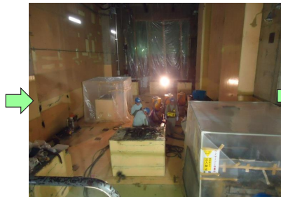
基礎コンクリートの解体撤去
