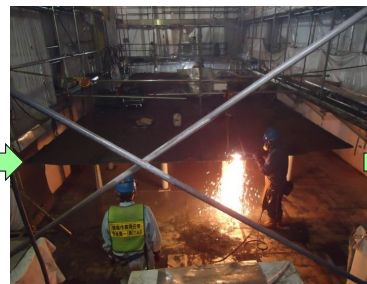
底部の解体撤去
