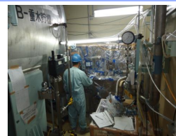
劣化重水貯槽、重水貯槽等のトリチウム除去作業の状況
