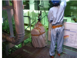
実機材（給水管逆止弁） の運搬作業
