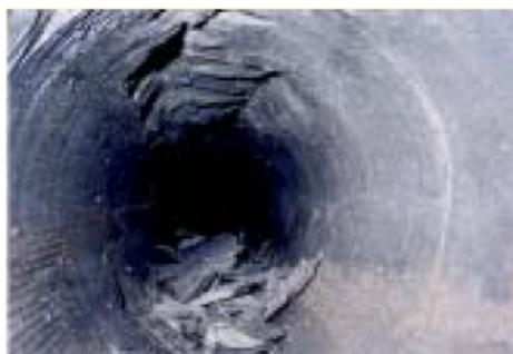
図 3.3-9 孔壁の破壊状況(東濃鉱山)
