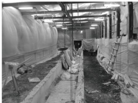
共同溝下部の撤去(汚染閉じ込め部)
