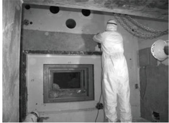
ホットセル内面の表面塗装剥離状況
