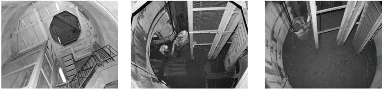
図 3.38 東濃鉱山の立坑部の充填作業
