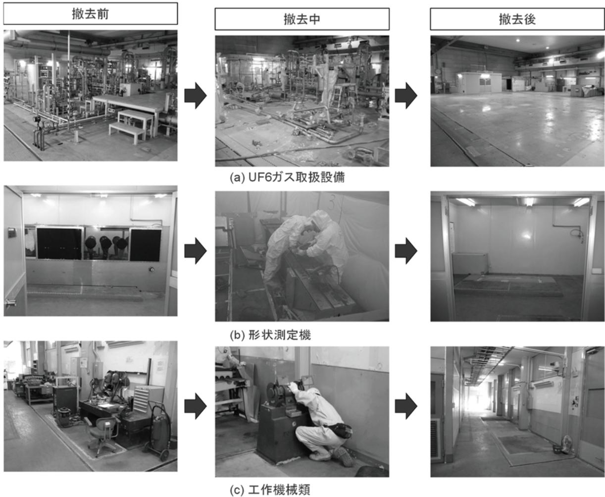
図 3.19 東海ウラン濃縮施設 L 棟試験設備の解体撤去状況
