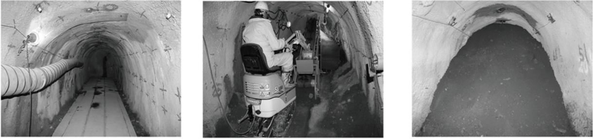
図 3.37 東濃鉱山の水平坑道部の充填作業
