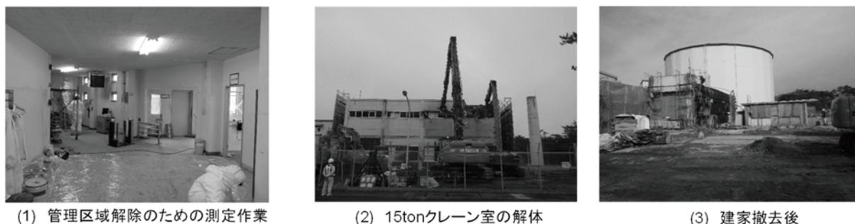
図 3.4 JRR-2 の廃止措置作業の状況
