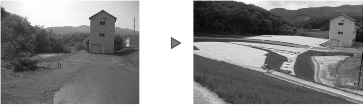
図 3.28 廃砂たい積場の跡措置（覆土設置前後）
