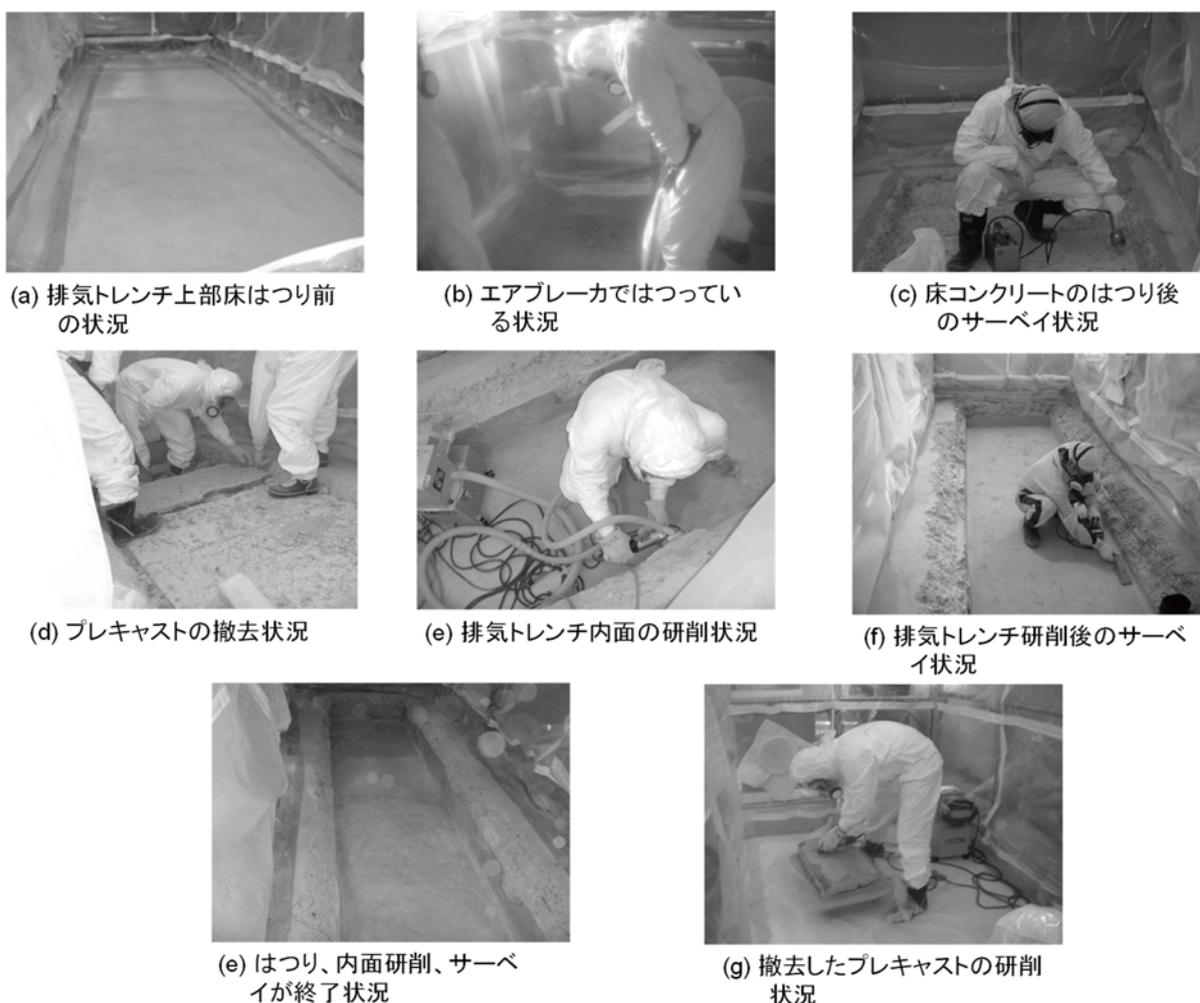
図 3.18 東海ウラン濃縮施設 H 棟排気トレンチはつり撤去の状況
