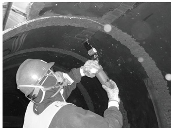
図 3.21 ふげんにおける海水配管内保護塗料剥離除去作業
