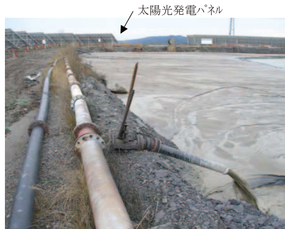
写真 4. 3-5 鉱さいのたい積、太陽光発電パネル設置
