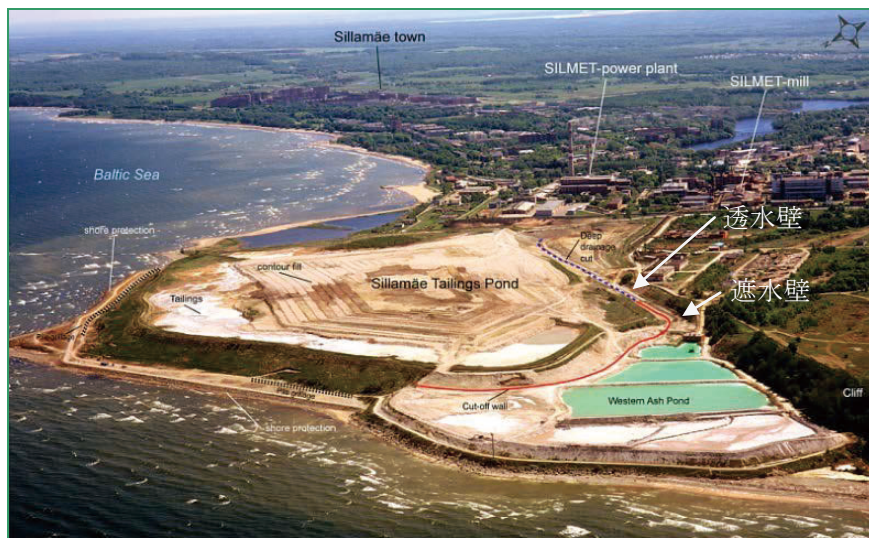
写真 4.3-9 Sillamäe 鉱さいたい積場における遮水壁及び透水壁等（跡措置中） 20) （再掲）
