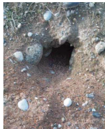
写真 3.3-3 動物による覆土への侵入 12)
