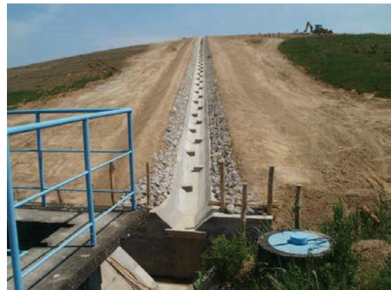
写真 4.3-14 コンクリート製排水路
