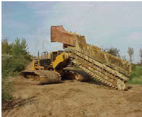
図 4.3-11 鉱さい安定化のための鉱さい脱水用トレンチ設置 22)
