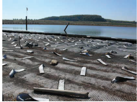
写真 4. 3-3 排水用ドレーン
