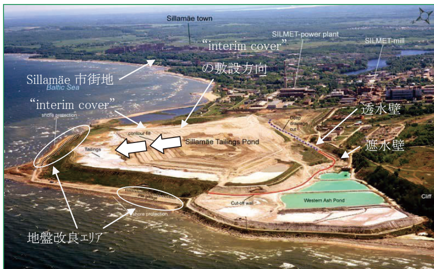
写真 4.3-9 Sillamäe 鉱さいたい積場における遮水壁及び透水壁等（跡措置中） 20)
