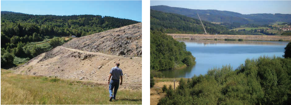
写真 4.3-7 現状のかん止堤（左）及びたい積場全景（右）
