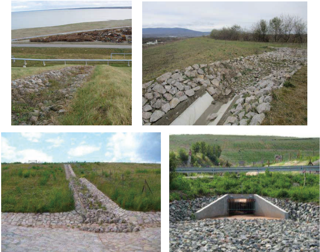
写真 4. 4-1 覆土頂部からの排水路（左上：Sillamäe 鉋さいたい積場、 右上：Pécs 鉋さいたい積場、左下・右下：Trünzig 鉋さいたい積場 27) ）
