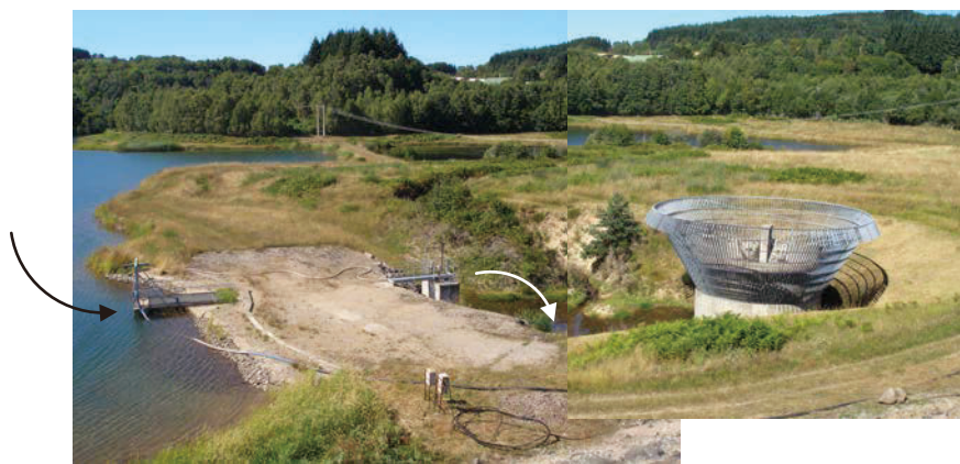
写真 4.4-3 豪雨時に場内水を河川へバypassさせる水路入口
