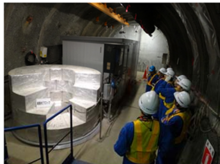
350m調査坑道での見学の様子
