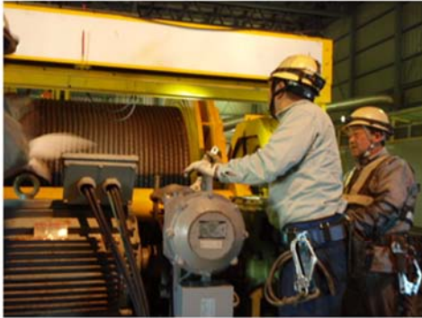
機械設備の維持管理の様子
