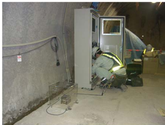
地震観測モニターの設置の様子
