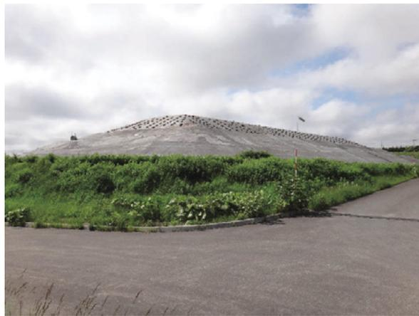
写真7 掘削土(ズリ)の保管状況
