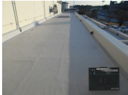
写真2.10.1(1)-2 ホットラボ 屋上防水 補修後
