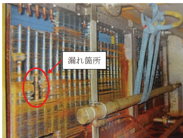
蒸気コイル補修前
