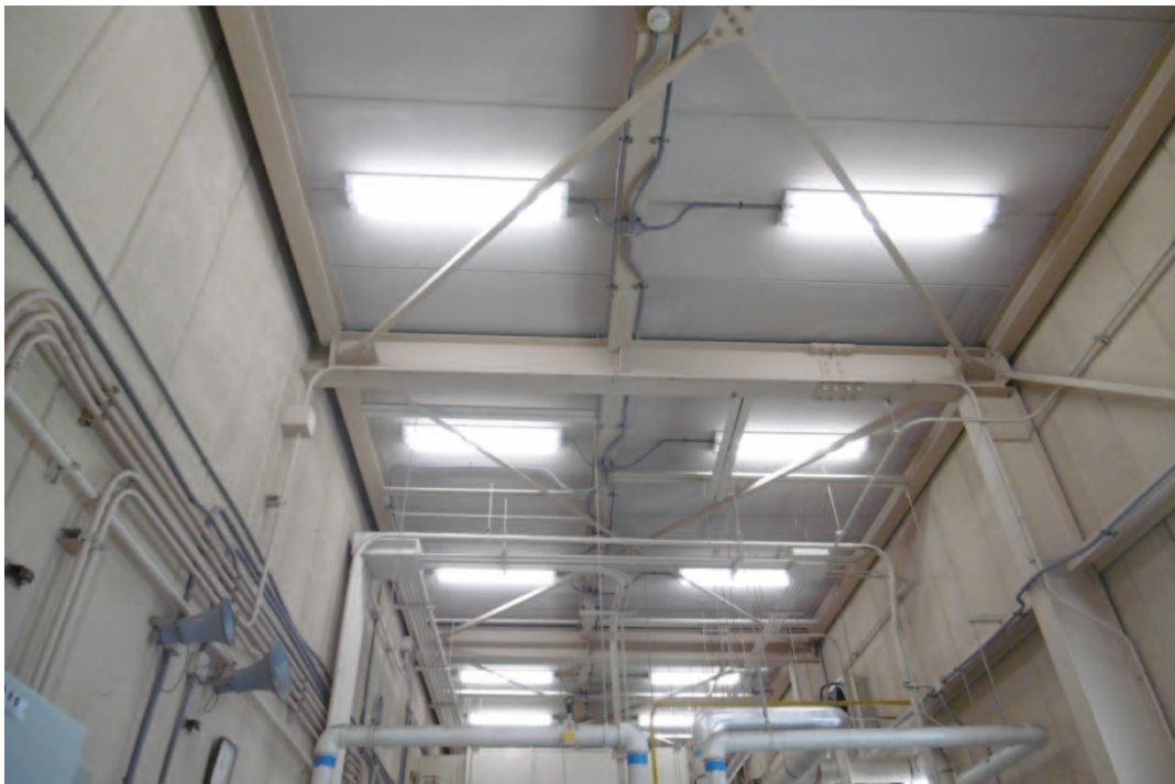
写真 2.1.15-1 更新した照明機器
