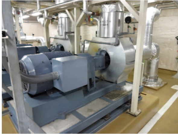
写真 2.1.6 冷凍機冷水一次ポンプ A 機 (冷水配管サイズ：300A)
