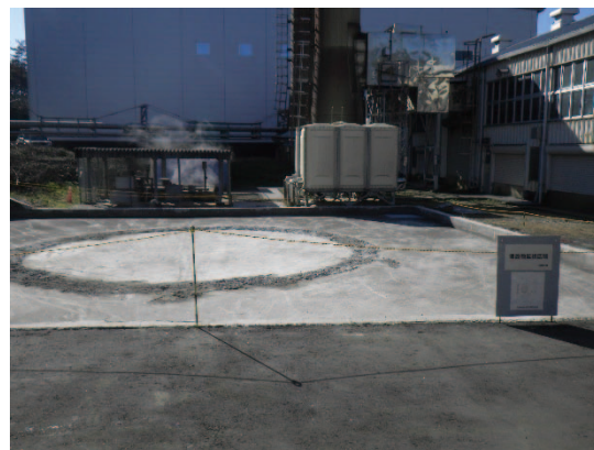
重油タンク撤去後
