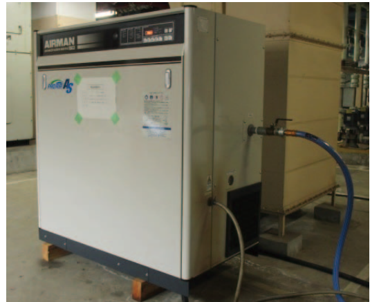
既設空気圧縮機、左がNo.1、右手前が仮設ベビコン 購入したスクリー型空気圧縮機 写真 2.1.11-1 タンデム加速器棟の空気圧縮設備
