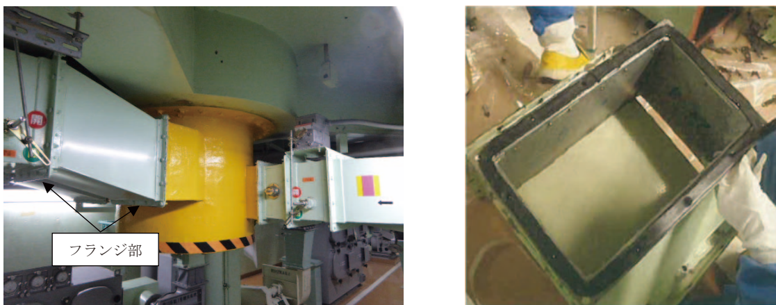
排気筒Ⅲ排気ダクト(接続部)
