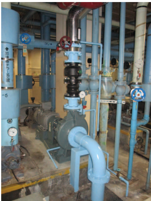
写真 2.1.11-2 更新した冷却水循環ポンプ
