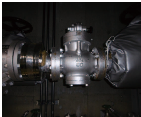
暖房用蒸気減圧弁更新前
