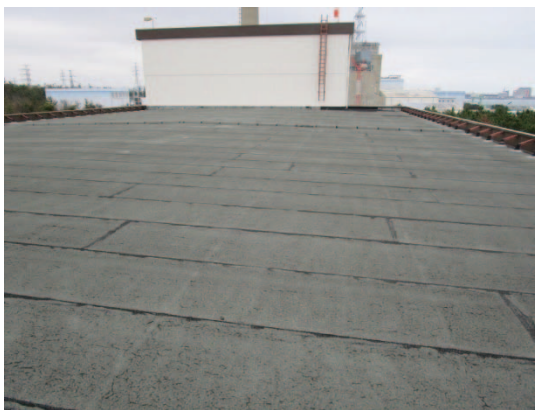
写真2.10.1(1)-3 燃料試験施設試験棟 屋上防水 補修前
