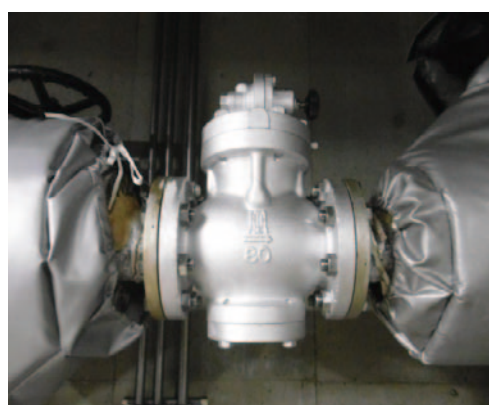
暖房用蒸気減圧弁更新後
