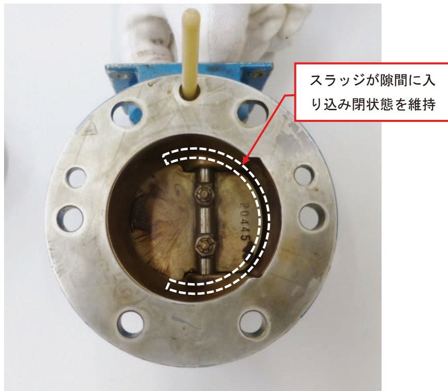
写真 2.7.1-5 ATV のバタフライ弁の閉状態(ATV 作動)
