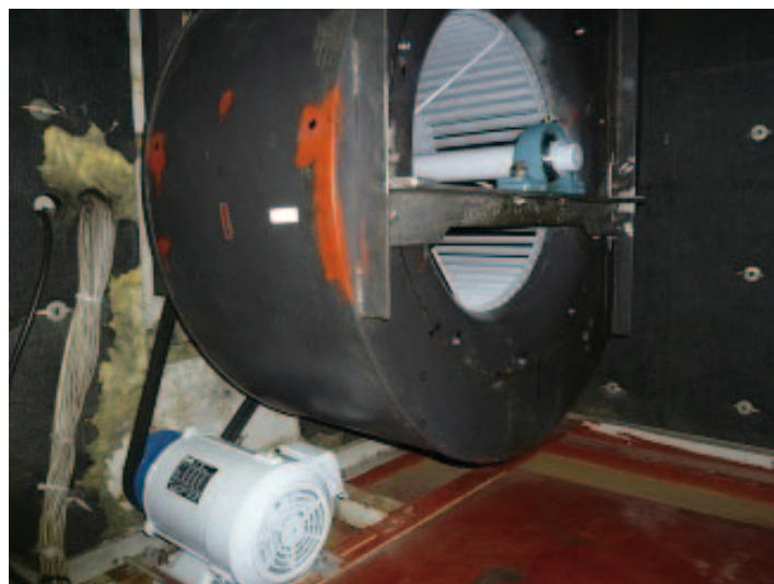
写真 2.1.3-2 更新したシロッコファン及び電動機
