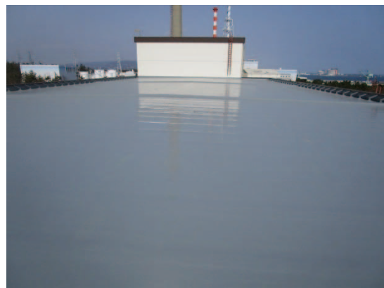
写真2.10.1(1)-4 燃料試験施設試験棟 屋上防水 補修後
