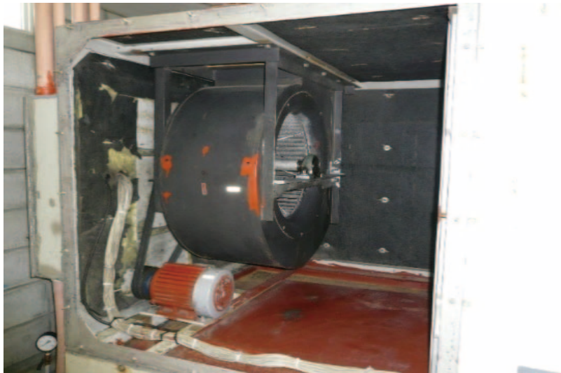
写真 2.1.3-1 腐食が見られた炉室系統空調機シロッコファン
