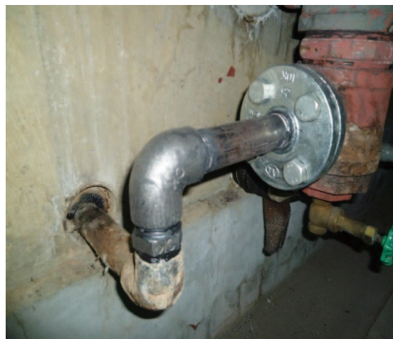
高圧蒸気還り管更新後
