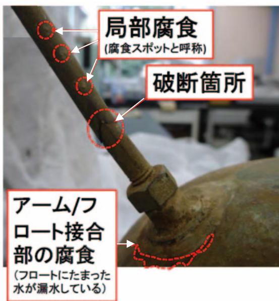
写真 2. 10. 1(6)-1 ボールタップ腐食状況
