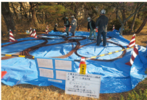
光ケーブル敷設状況
