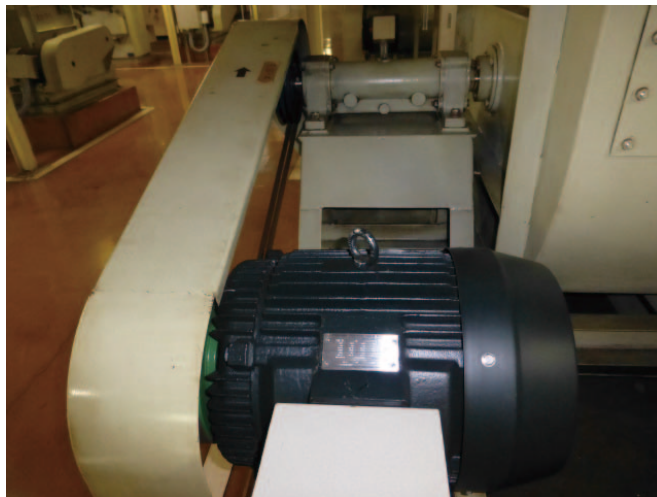
写真 2.1.12-1 更新後電動機
