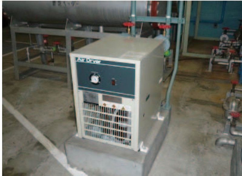
写真 2.1.3-3 更新した除湿機
