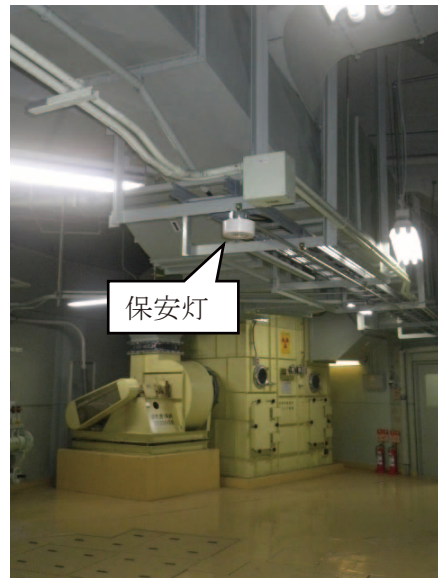
写真 2.1.17-2 炉室内地下保安灯
