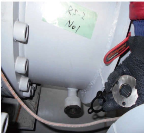
写真 2.1.14-1 冷凍機サイトグラス補修(サイトグラスパッキン交換及び気密試験)
