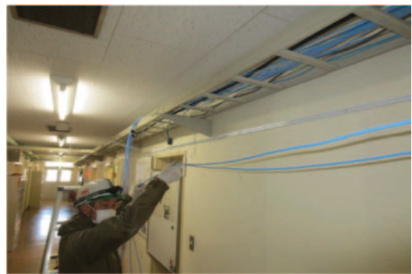
LAN ケーブル敷設状況
