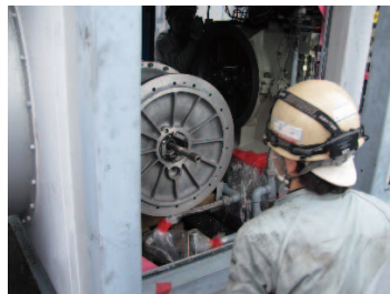
写真 2.1.19-4 ギヤボックス連結シャフト組込み
