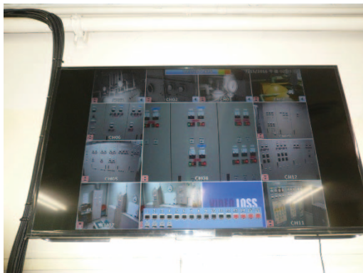
写真 2.1.18-1 居室の監視画面
