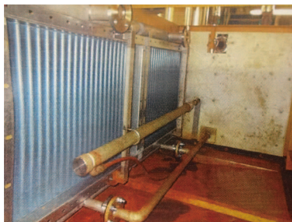
蒸気コイル補修後
