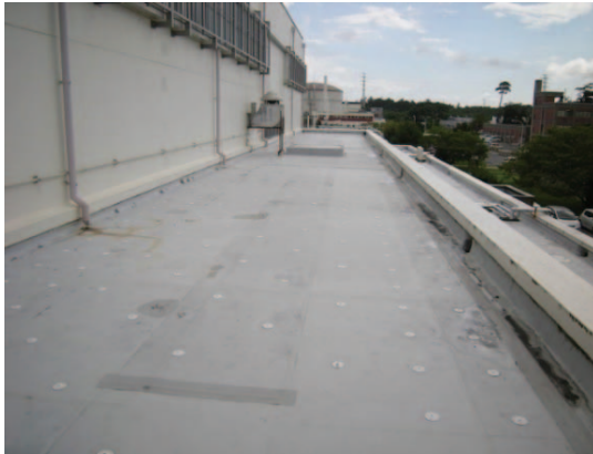
写真2.10.1(1)-1 ホットラボ 屋上防水 補修前
