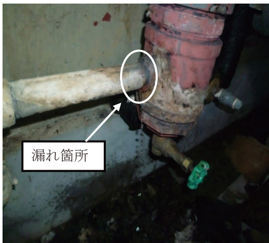
高圧蒸気還り管更新前
