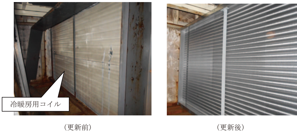
写真 2.1.1-2 実験室系空調機冷暖房用コイル
