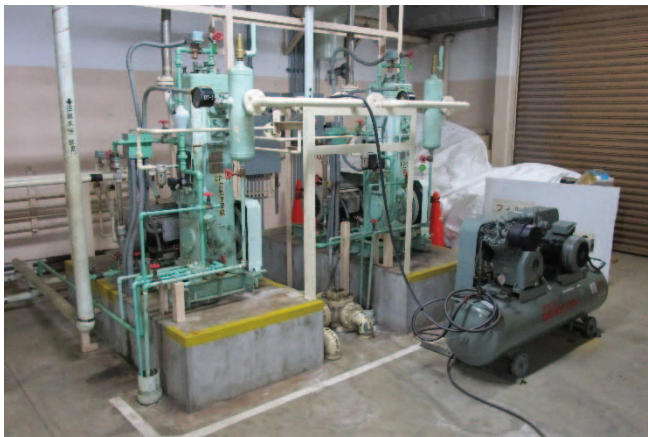
既設空気圧縮機、左がNo.1、右手前が仮設ベビコン 購入したスクリー型空気圧縮機 写真 2.1.11-1 タンデム加速器棟の空気圧縮設備
