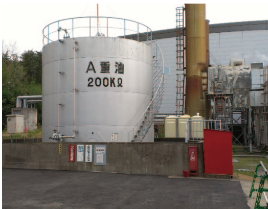
重油タンク撤去前
