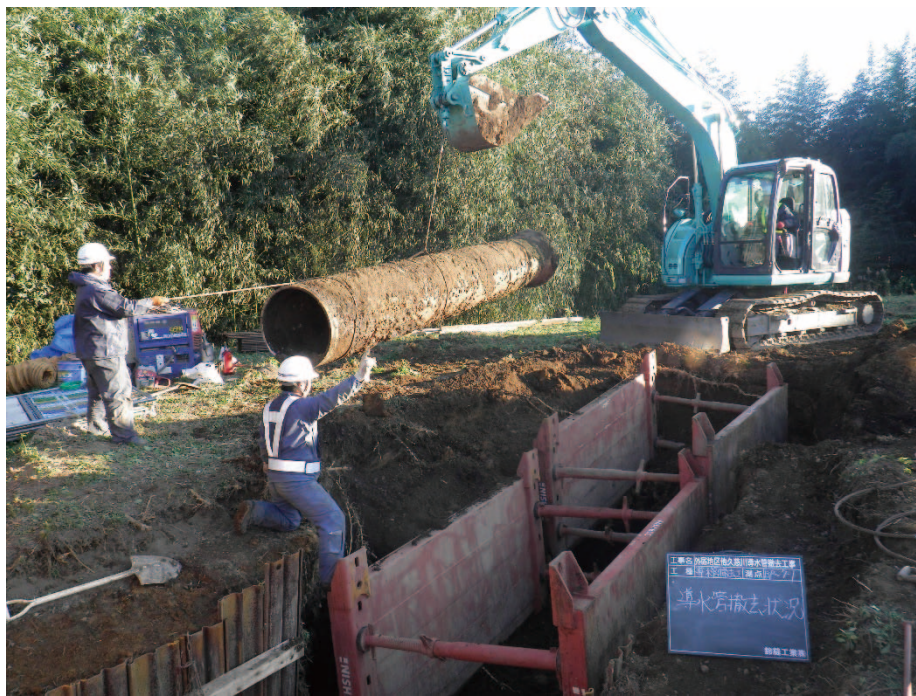
写真 2.10.2-1 久慈川導水管撤去状況(石神外宿地区民地部)
