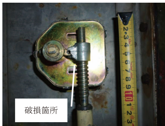
写真 2.1.6-4 内部破損箇所
