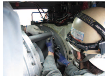
写真 2.1.19-5 新エンジン取り付け
