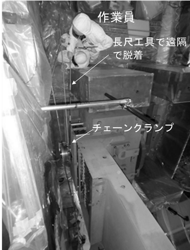
図 5.5-2 実際のチェーンクランプ交換作業の様子。bs2 電磁石下流部の作業時の真上からの写真。
