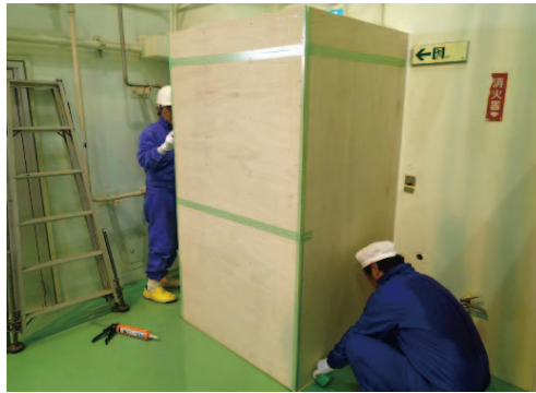
図 2.1.3 間仕切り作業状況
