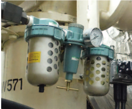
図 2.1.4 隔離弁の減圧弁
