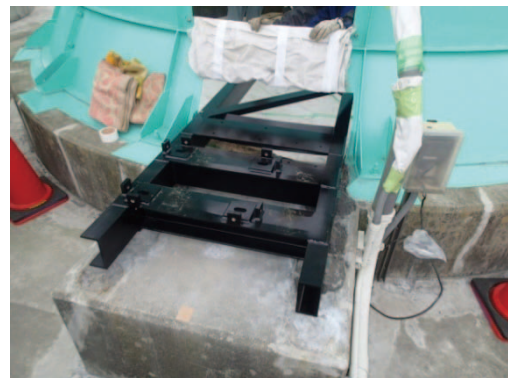
図 2.1.8 ベース架台の据付状況
