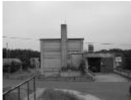
ウラン濃縮研究棟
