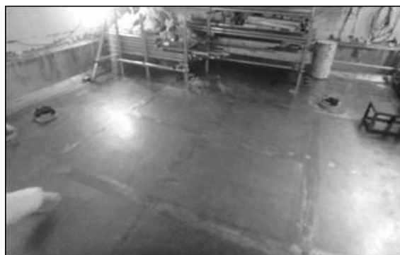
図 6.1.2-4 2016 年度の撤去作業後の LV-1 室の状況
