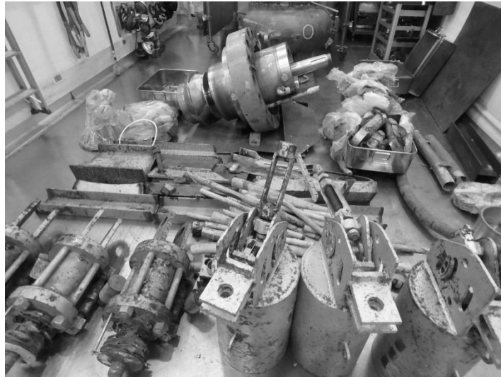
図 3.4.2-2 角型鋼製容器（JPDR）の主な内容物
