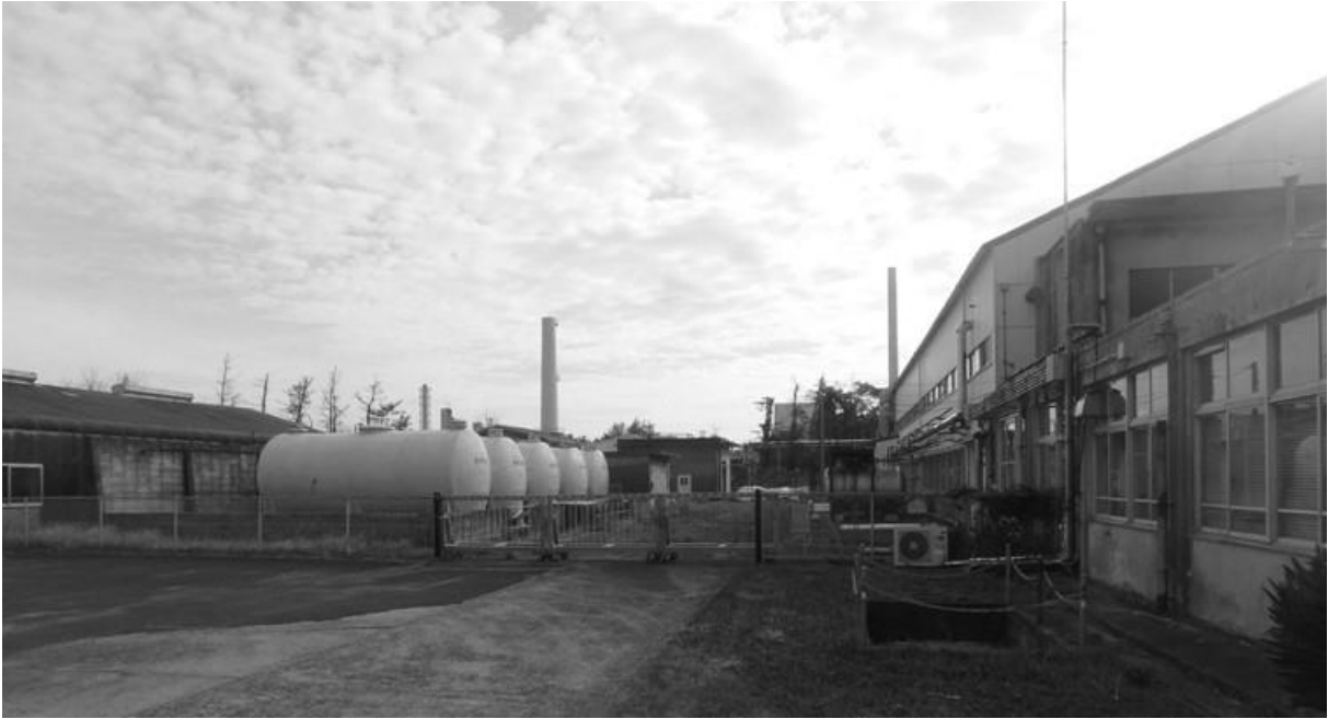
図 5.2.2 低レベル廃液貯槽の状況
