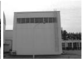
保障措置技術開発試験室施設 (SGL)
