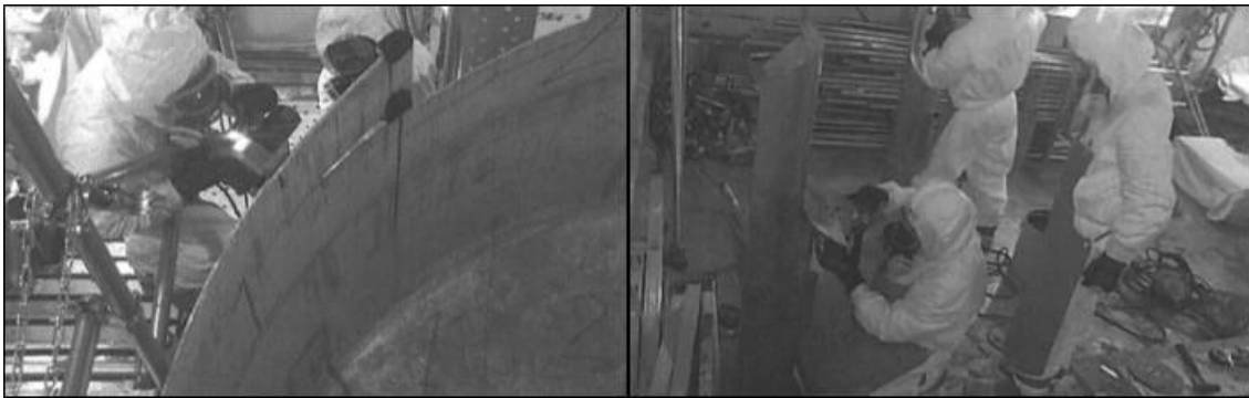
図 6.1.2-3 LV-1 冷却水ジャケット及び脚部の撤去作業状況
