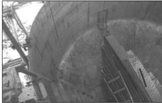
図 6.1.2-2 2016 年度の撤去作業前の LV-1 室の状況
