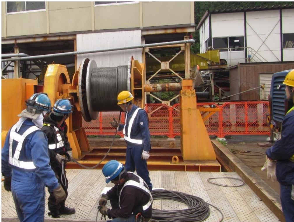
(主立坑) 仮設備 エレベーターワイヤーロープ交換
