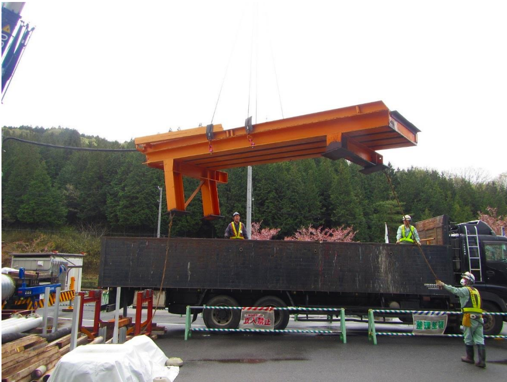
（主立坑）地上仮設備 コンクリート荷卸し用斜路撤去
