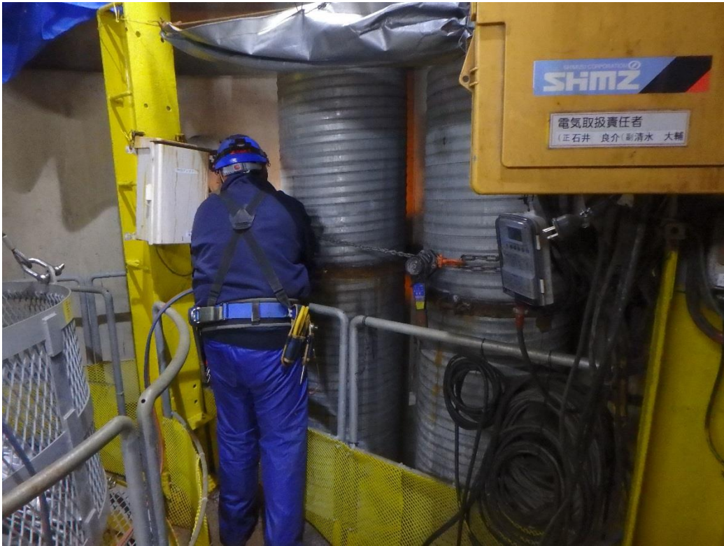
(換気立坑) 立坑内仮設備 深度 30m~300m 風管バンド交換
