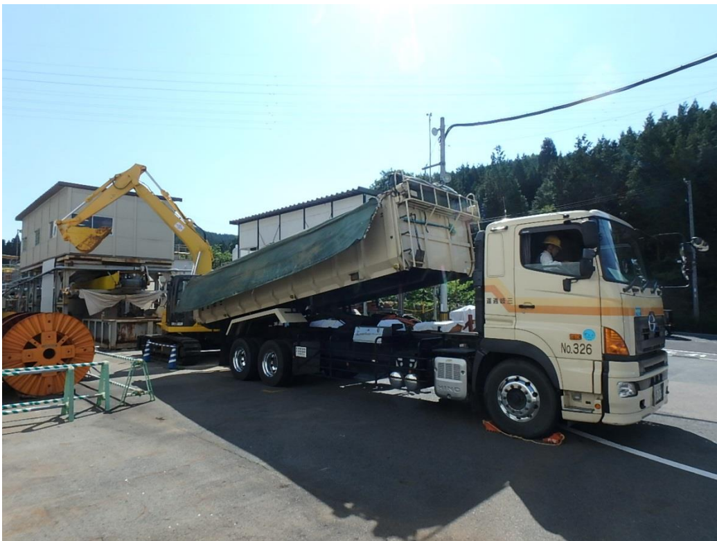
(換気立坑) 産業廃棄物搬出 脱水ケーキ積込状況
