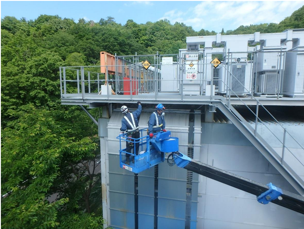
(換気立坑) 地上仮設備 維持管理作業状況 (受変電設備塗装)
