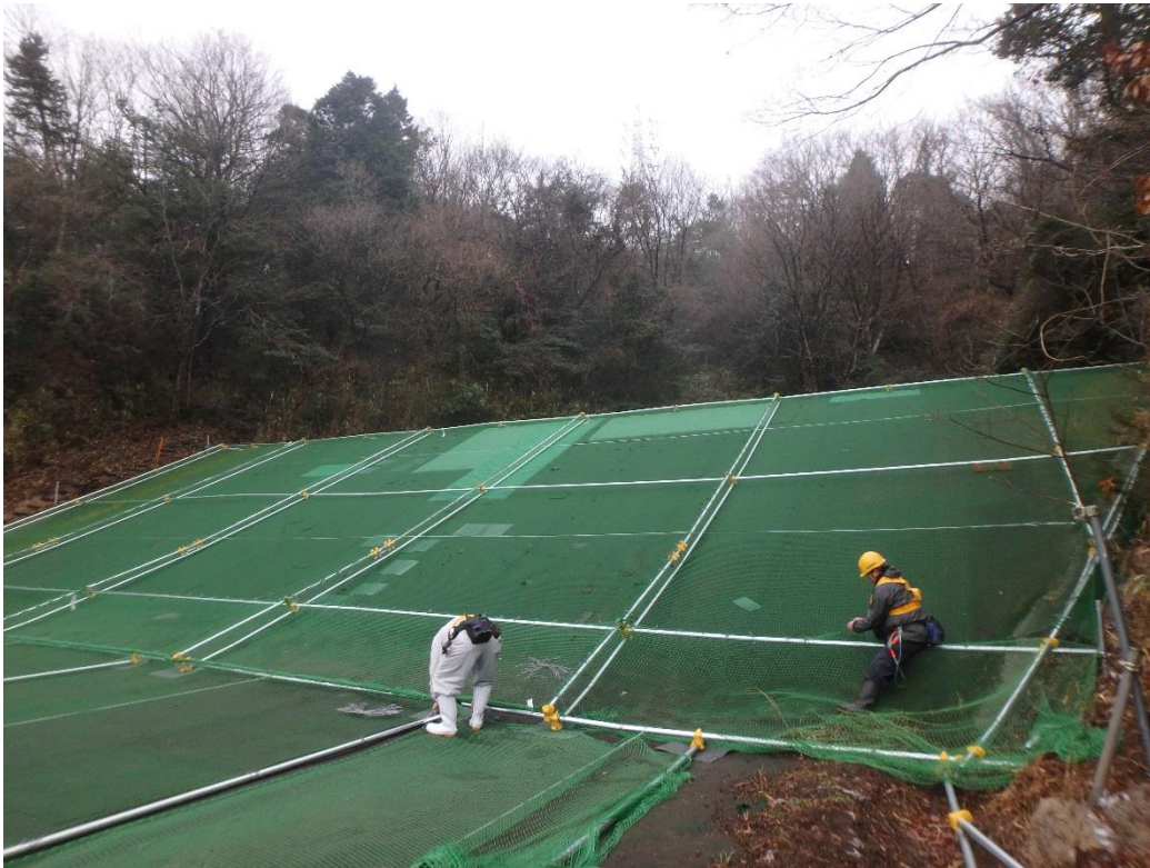
(換気立坑) 堆積場 掘削土保護マット防護 設置状況
