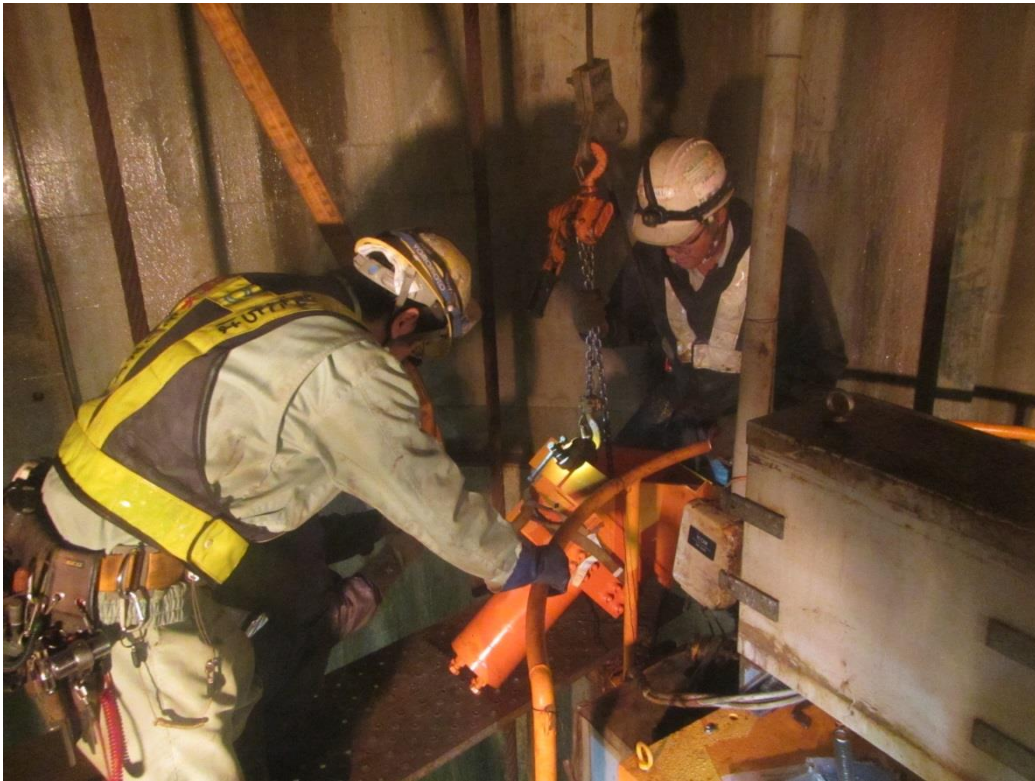
(主立坑) 立坑内仮設備 エレベーター非常停止装置交換
