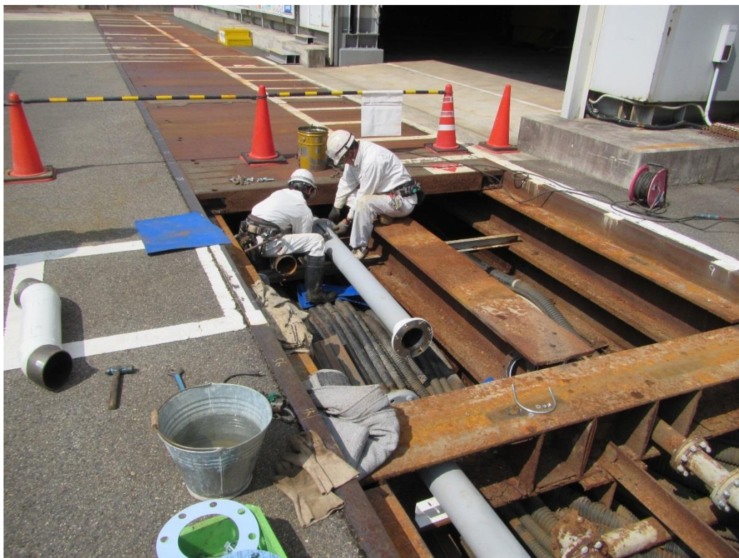
(主立坑) 地上仮設備 覆工板下配管交換
