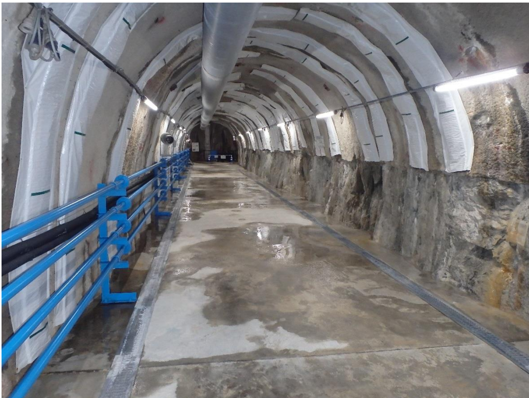
(換気立坑) 深度 500m 研究アクセス南坑道 その7工事着手時状況
