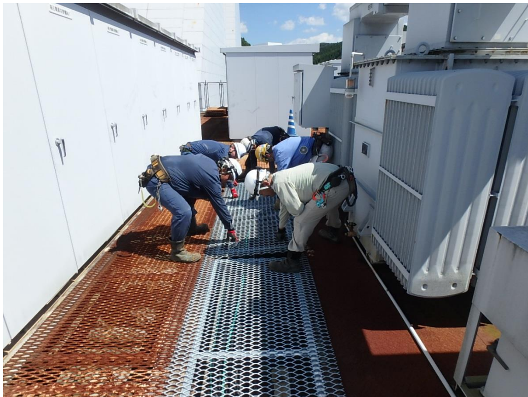
(換気立坑) 地上仮設備 受変電設備改修 (床材交換)
