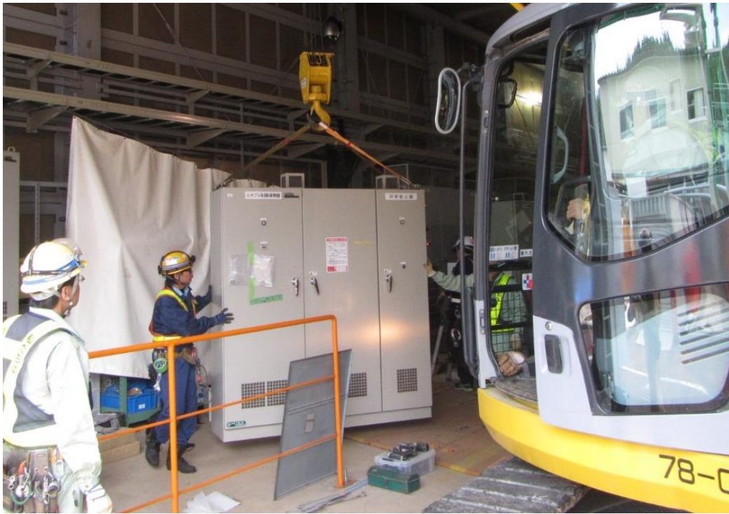
(主立坑) 地上仮設備 巻上げ機制御盤交換
