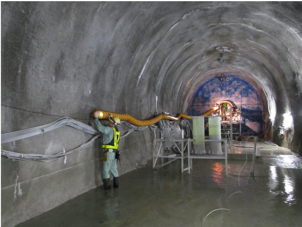
(主立坑) 冠水坑道試験準備 換気設備設置状況
