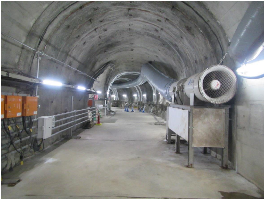
(主立坑) 深度 500m 研究アクセス北坑道 竣工状況
