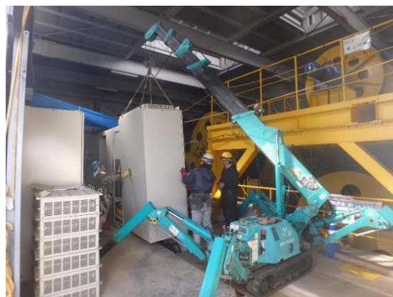
写真5.3-3 換気立坑巻上設備制御盤の交換作業（地上巻上機室）
