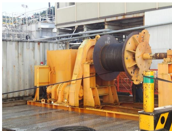
写真5.3-2 主立坑エレベーターのワイヤーロープ交換 （これまで使用してきたロープの巻き取り状況）
