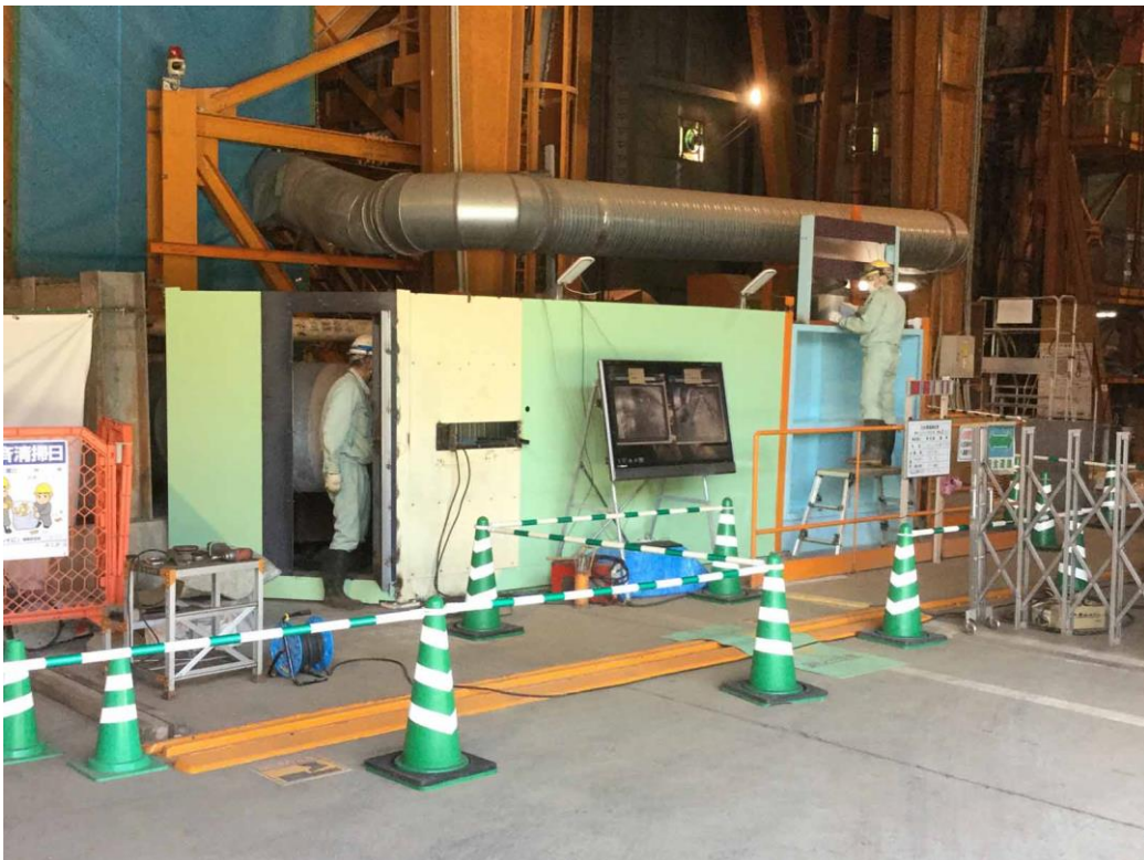
(主立坑) 地上仮設備 入出坑管理システム改修
