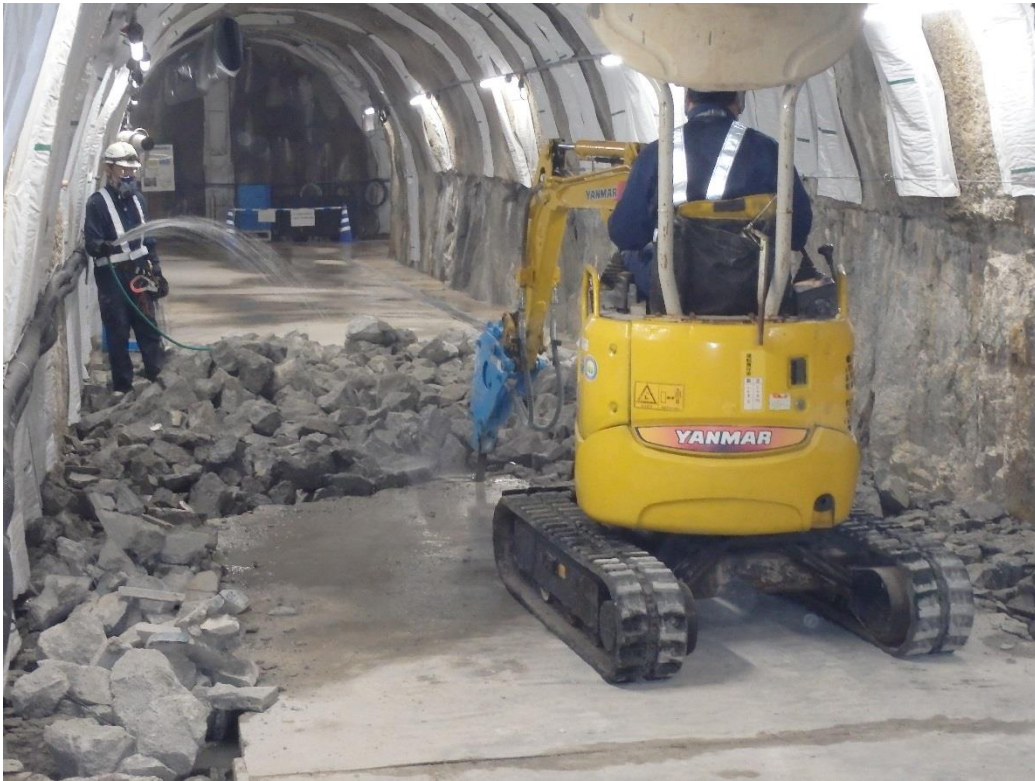
(換気立坑) 深度 500m 研究アクセス南坑道 床版取壊し状況
