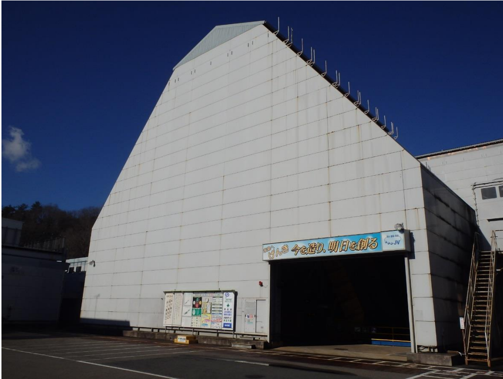
(換気立坑) 地上設備 その7工事着手時 音防音ハウス
