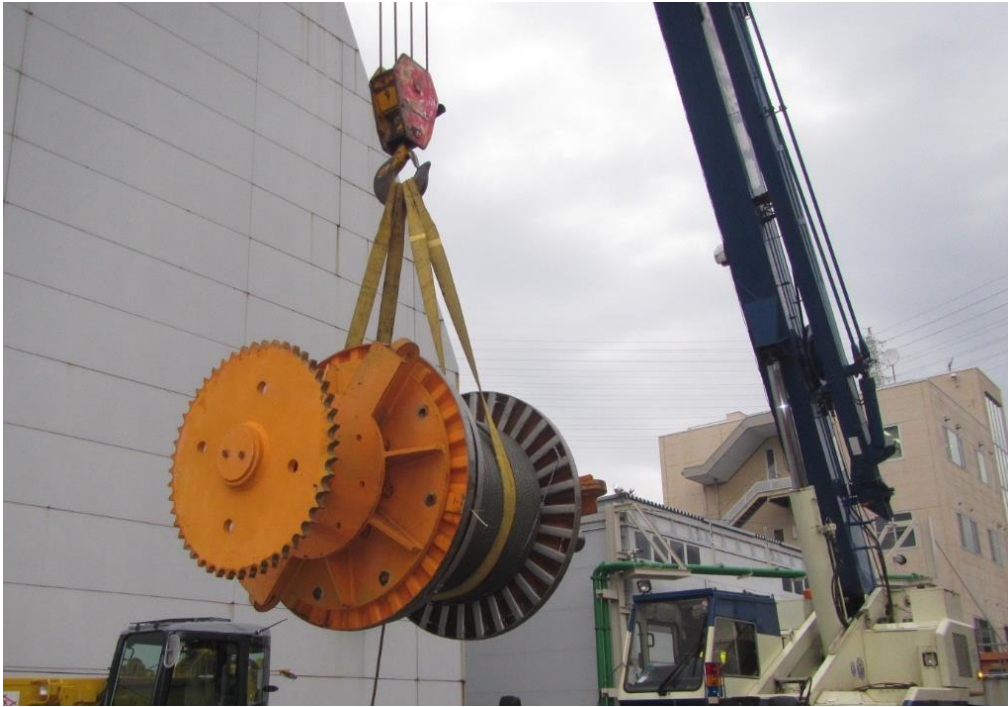
(主立坑) 仮設備 エレベーターワイヤーロープ交換
