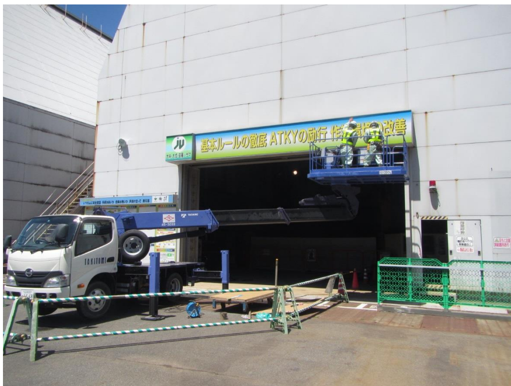
(主立坑) 地上仮設備 安全看板整備状況
