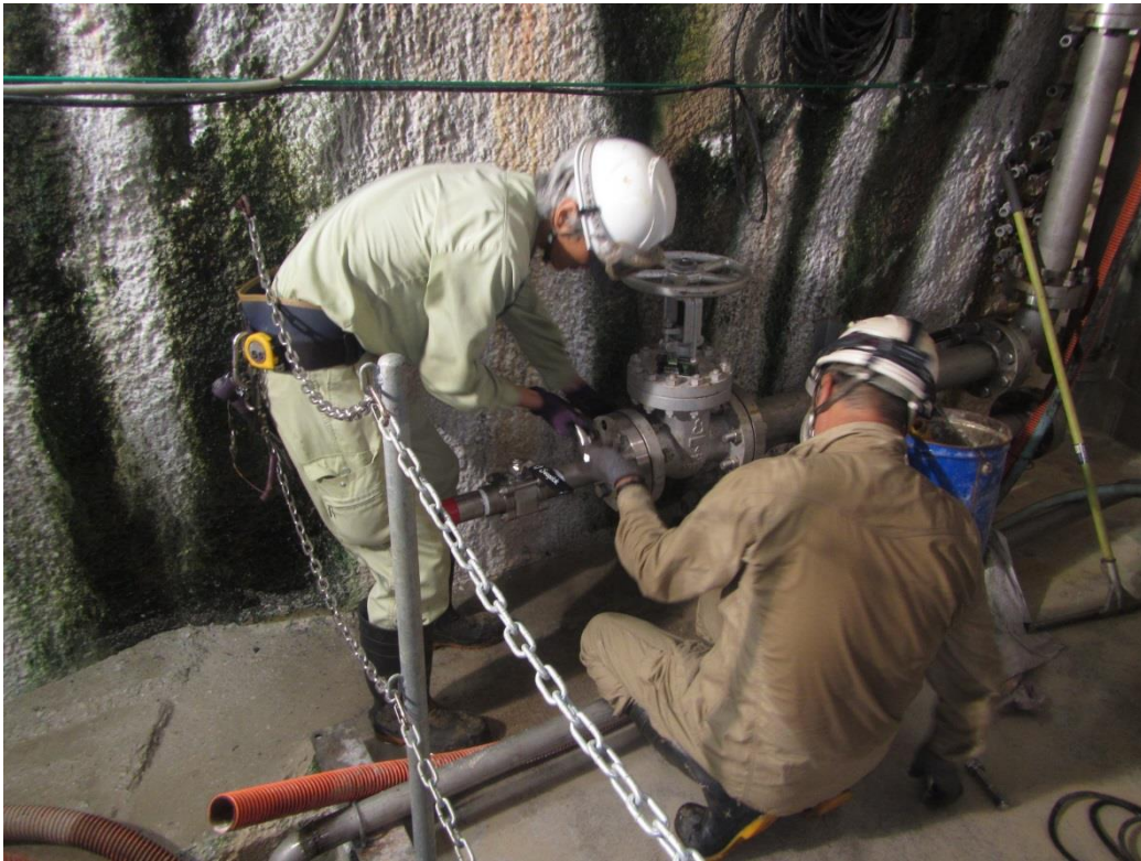
(主立坑) 冠水坑道試験準備 バルブ設置状況
