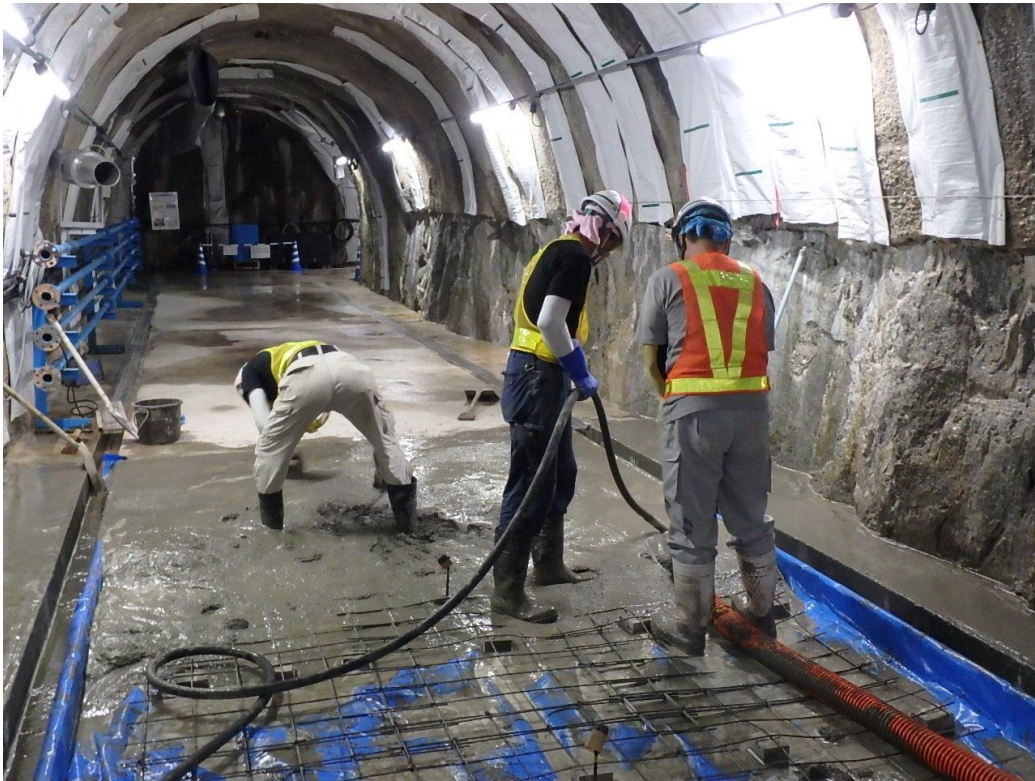
(換気立坑) 深度 500m 研究アクセス南坑道 床版復旧 (コンクリート打設)
