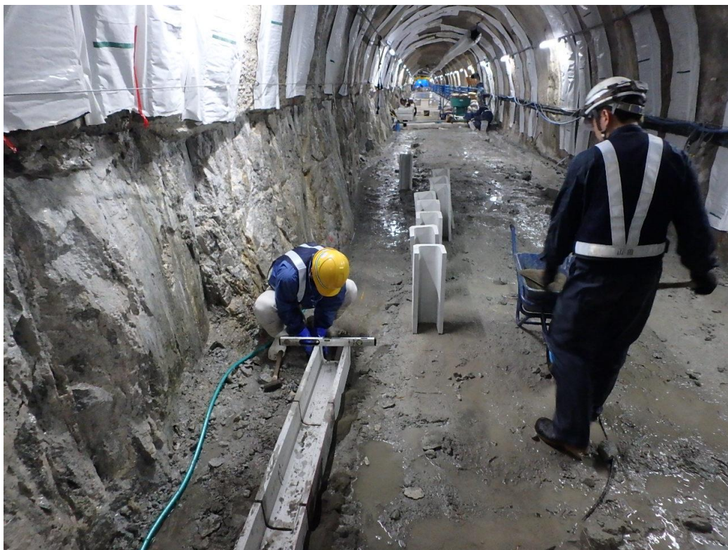
(換気立坑) 深度 500m 研究アクセス南坑道 排水側溝設置状況
