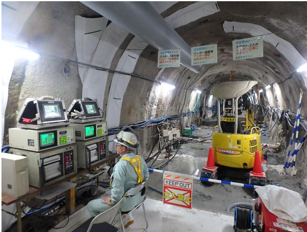
(換気立坑) 深度 500m 研究アクセス南坑道 ポストグラウチング注入状況
