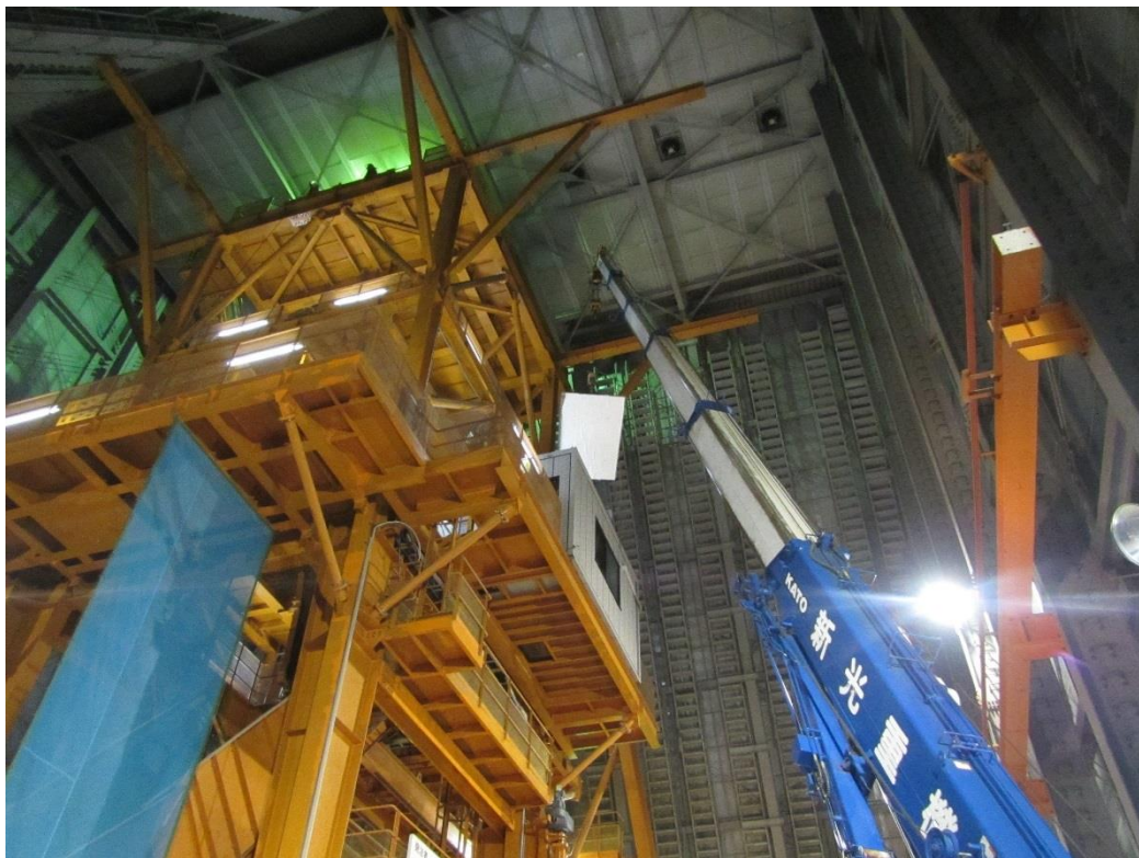
(主立坑) 地上仮設備 運転室操作盤交換
