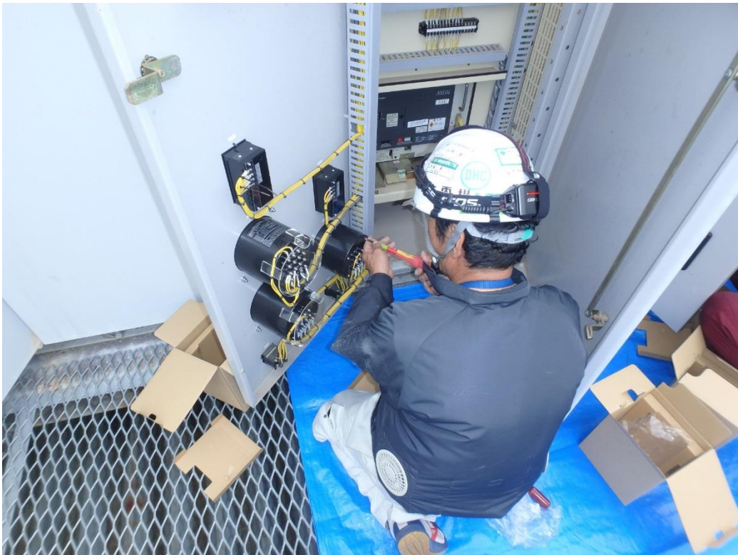
(換気立坑) 地上仮設備 受変電設備改修 (継電器及びリレー交換)
