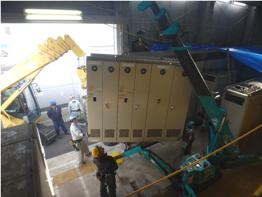
(換気立坑) 地上仮設備 巻上機制御盤撤去
