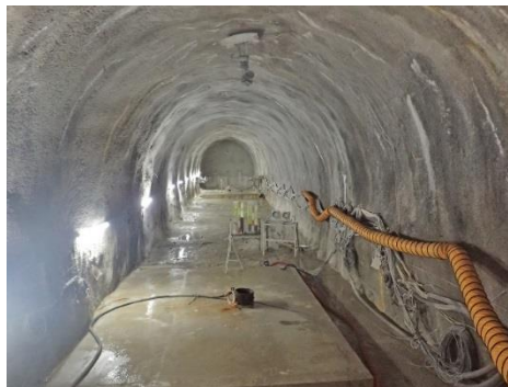
写真5.1-1 冠水坑道内の環境整備（排水、換気及び照明設備設置）
