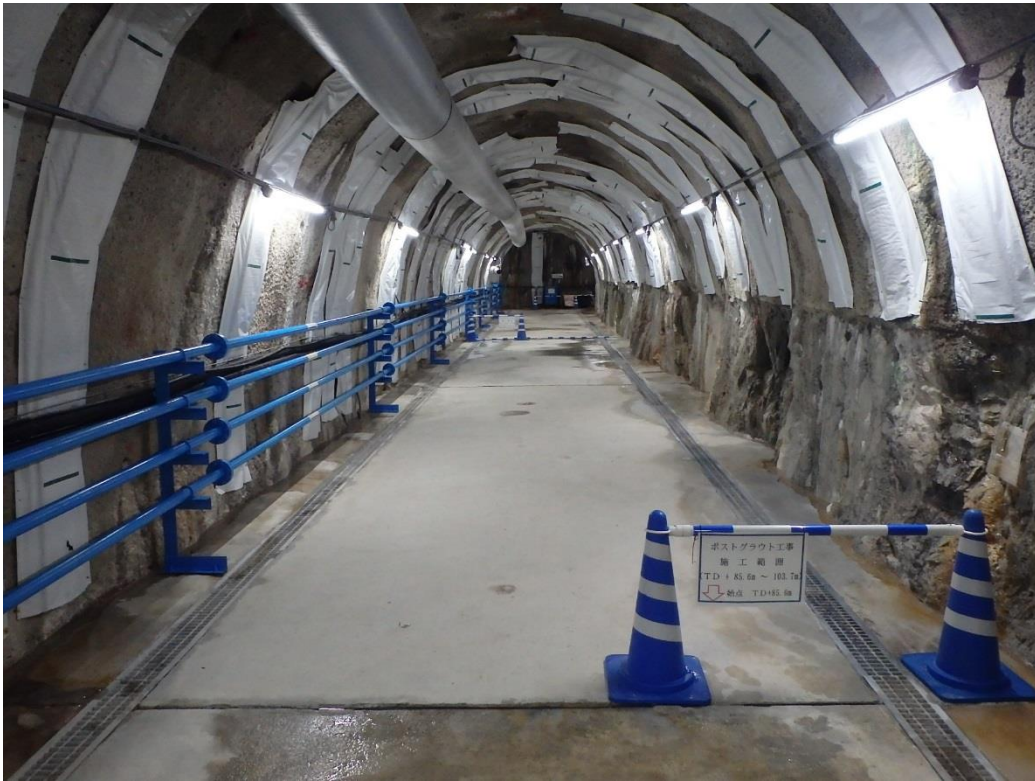
(換気立坑) 深度 500m 研究アクセス南坑道 竣工状況
