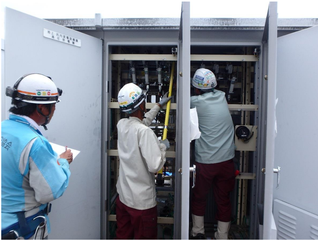
(換気立坑) 地上仮設備 受変電設備改修 (高圧開閉器交換)
