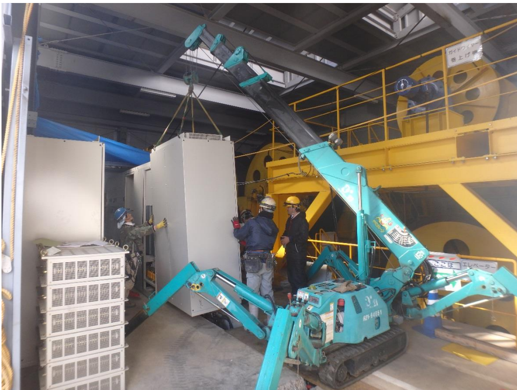
(換気立坑) 地上仮設備 巻上機制御盤設置
