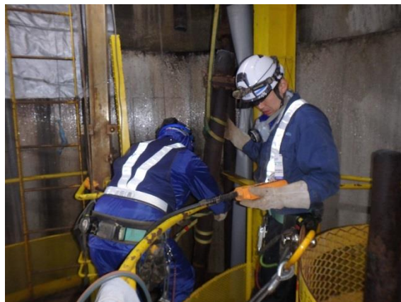
写真5.3-1 配管の撤去（換気立坑深度200m～300m区間での作業状況）
