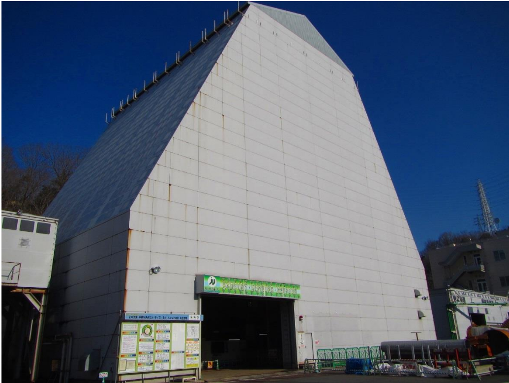
（主立坑）地上設備 その7 工事着手時 櫓防音ハウス
