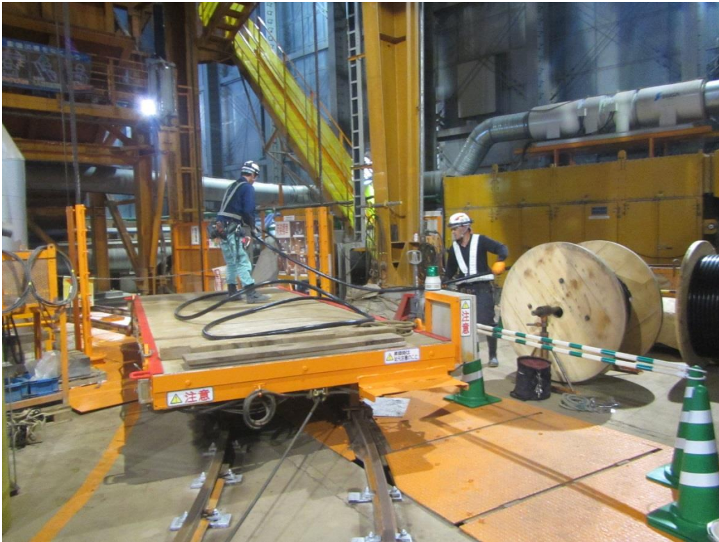
(主立坑) 坑内仮設備 高圧ケーブル敷設替
