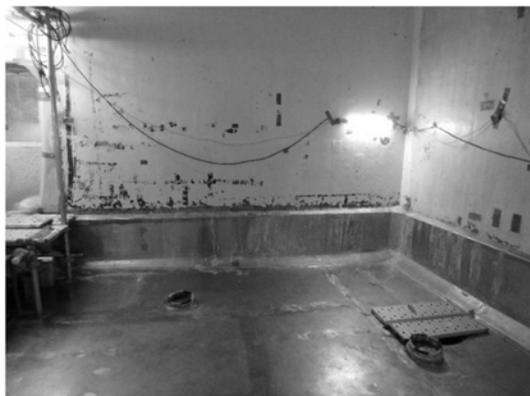
図 6.1.2-5 LV-1 解体用排気設備撤去後の LV-1 室の状況
