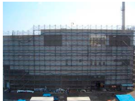
写真 3.2-3 建家外観（平成 29 年 3 月 28 日撮影）
