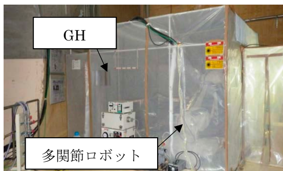
図 2.3.2-4 GH 設置状況
