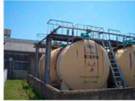
廃液貯槽周辺に設置されていた点検架台、支柱等
