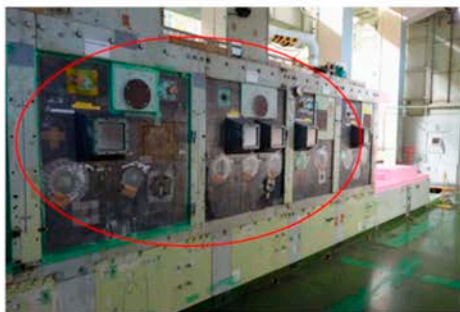
平成27年度に解体したウラン マグノックス用鉛セル(4基)
