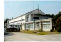
液体処理場の外観
