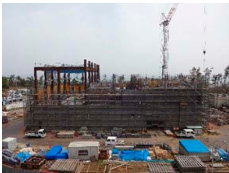
写真 3.2-2 建家外観（平成 28 年 3 月 30 日撮影）
