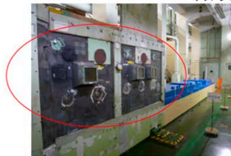
平成28年度に解体したウラン マグノックス用鉛セル(2基)
