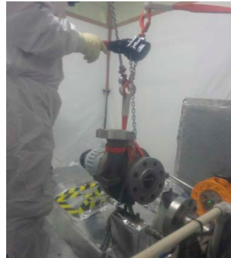
配管等の解体撤去状況
