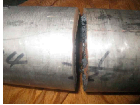
図 2.3.2-7 レーザー切断後の配管
