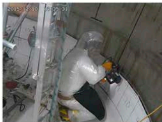
平成27年度に解体した 廃液貯槽LV-1下部切断作業
