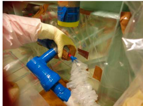
図 2.3.1-8 除染ヘッドの挿入状況
