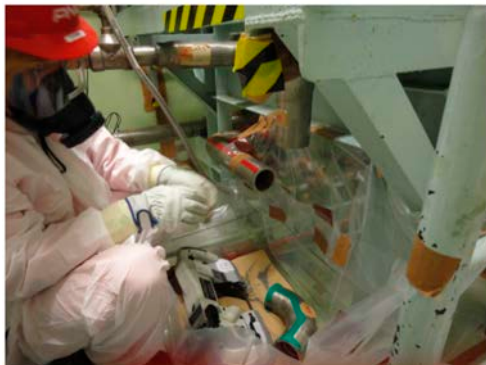
図 2.3.1-7 除染対象配管切断の状況
