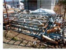
廃液貯槽周辺に設置されていた点検架台、支柱等
