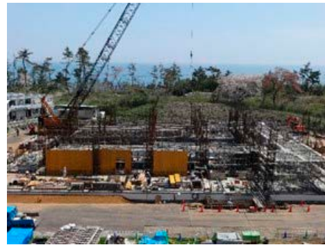
写真 3.2-1 建家外観（平成 27 年 4 月 22 日撮影）
