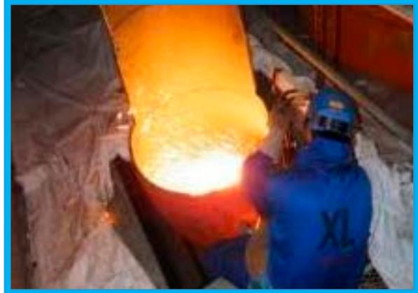
高圧タービン排気配管の切断
