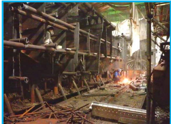
A 復水器下部構造物の切断
