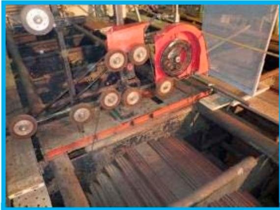
ワイヤーソーを使った冷却管群の一括切断
