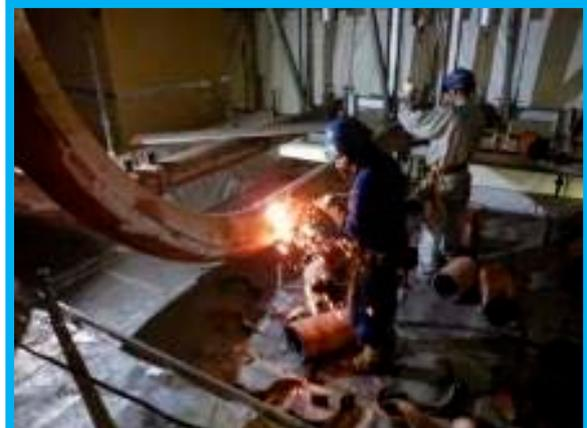
主蒸気管(高圧タービン入口配管)の切断
