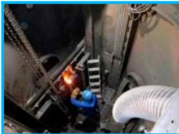
湿水分離器内部構造物の切断
