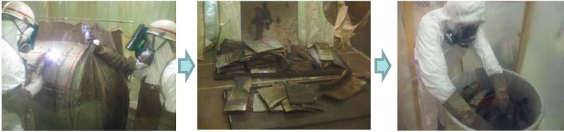
写真 2.6.1-10 大型汚染機器（コールドトラップ）解体
