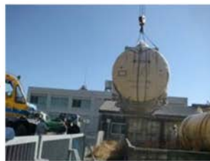
廃液貯槽の取り外し
