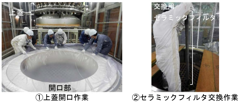
図 1.4-2 フィルタ類の保守試験状況
