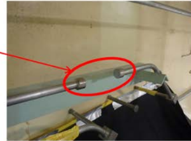
溶液燃料移送配管を切断
