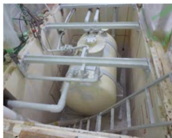
写真 2.6.3-5 床ドレンピット内除染後の例
