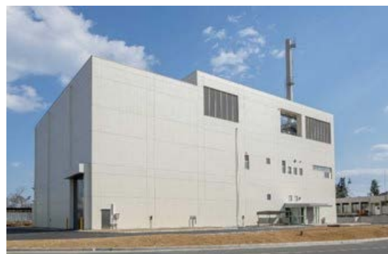
写真 3.2-1 建家外觀（平成 30 年 2 月 21 日撮影）
