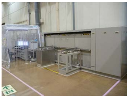
写真 2.6.1-3 電離イオン測定装置
