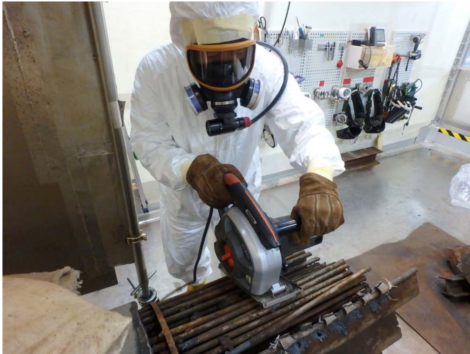
写真 3.1-1 解体分別保管棟での解体分別処理
