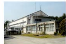
液体処理場の外観
