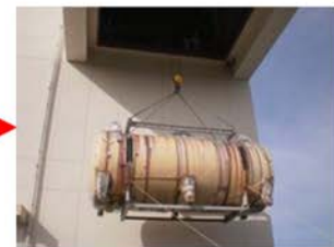
解体分別保管棟へ搬入
