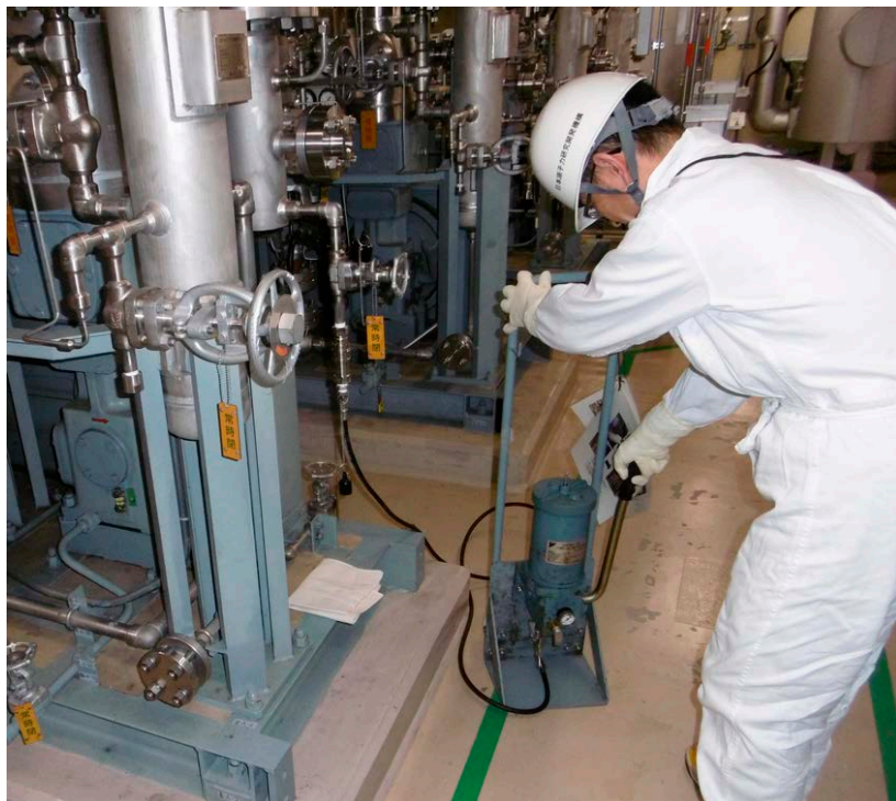
図 2.2.2 シールオイル補給作業中の様子
