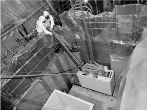
図 5.5-1 キャスクを標的容器上に設置している作業の様子
