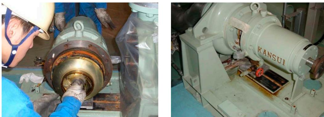
図 3.1.3 補機冷却ポンプ分解点検の状況
