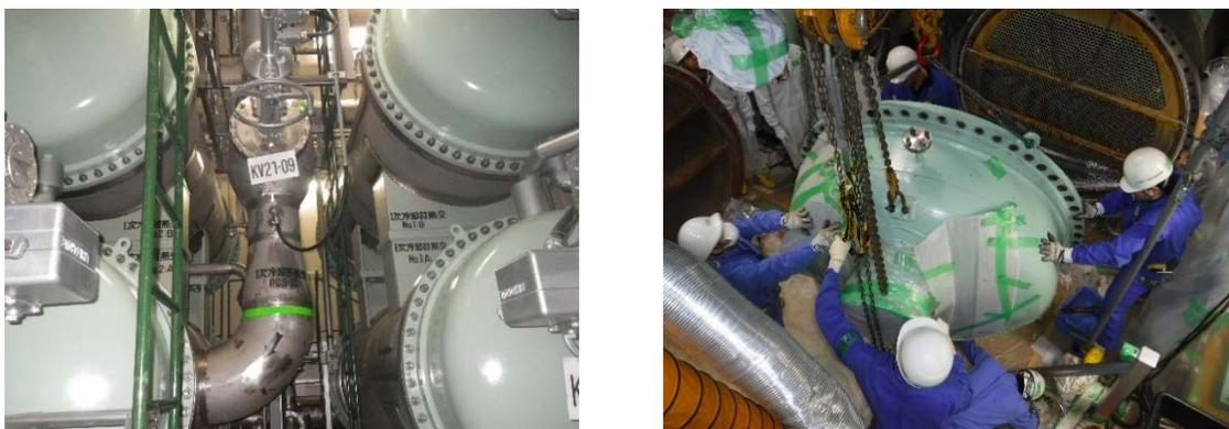
図 3.1.1 1次冷却材熱交換器開放点検状況
