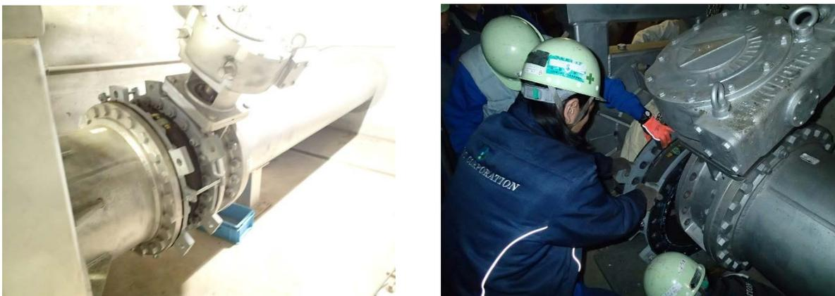
図 3.1.4 2 次冷却系伸縮継手更新状況
