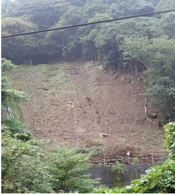
伐採・法面清掃状況
