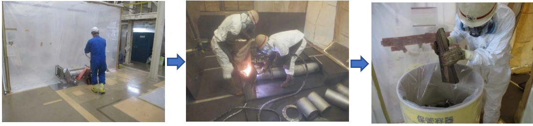
図 2.2.1-4 汚染機器（トラップ類）解体（細断収納）
