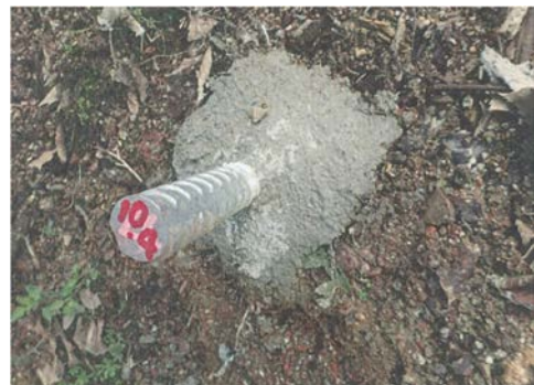
グラウト状況
