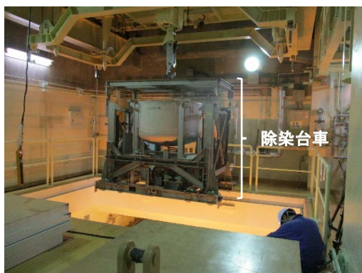
①除染台車吊上げ作業
