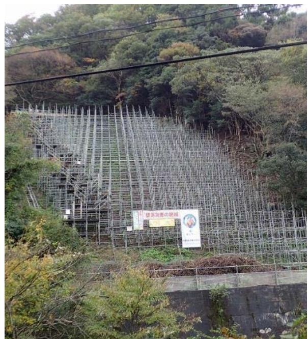
足場設置状況
