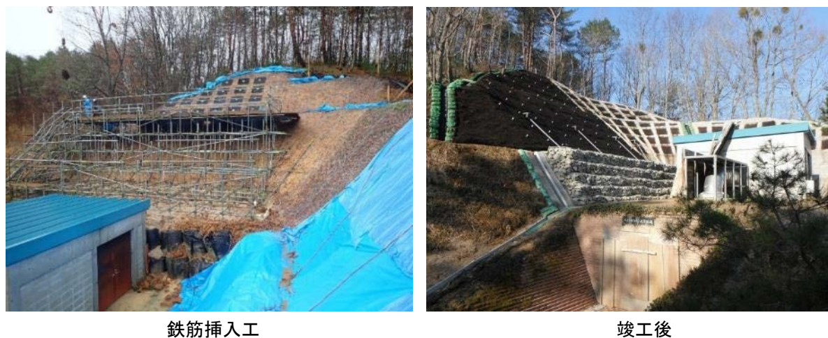
図 2.2.5-5 夜次 2 号坑口（見学坑道）法面の地すべり対策の工事状況
