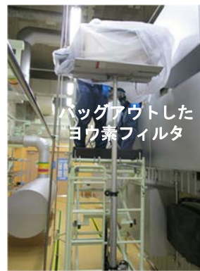
②電動リフトによる降下作業
