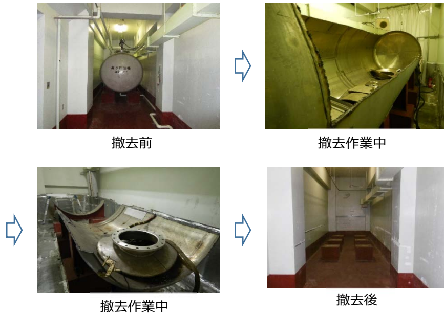
図 2.1.5-3 廃水タンクの撤去
