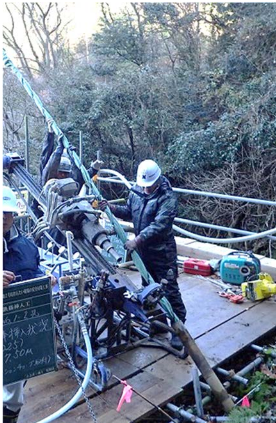
鉄筋挿入作業状況
