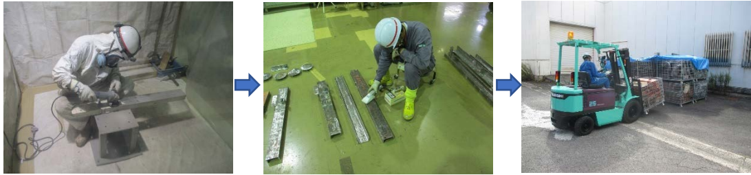
図 2.2.1-5 解体収納物の NR 対応
