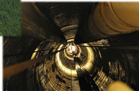
主立坑(掘削深度:500.4m、内径6.5m)
