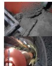
原位置での隙間充填・除去技術の確認
