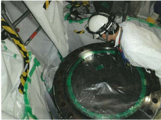
図 2.5.2 ガスケット溝の外観検査
