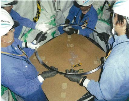
図 2.5.4 新規ガスケット取付け
