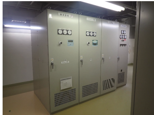
設備全景（施工後）
