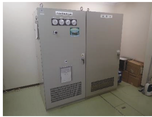
設備全景（施工後）
