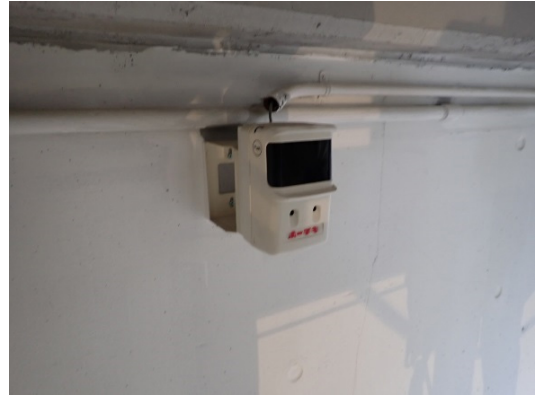
施設全景（施工後）
