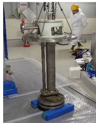
写真1.3 機排棟雑排水サンプポンプ
