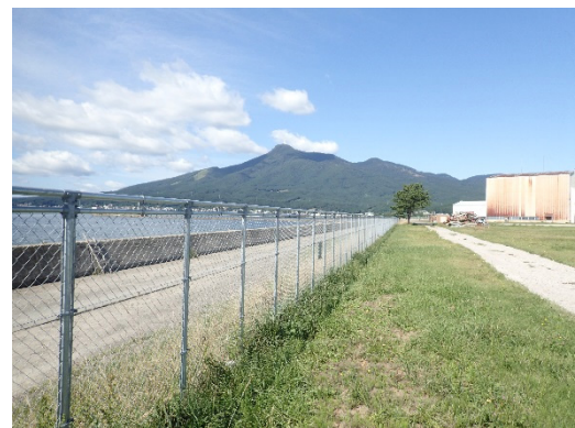
施設全景（施工後）
