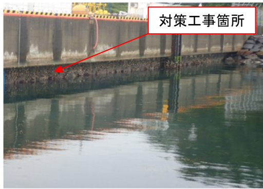
施設全景（施工前）
