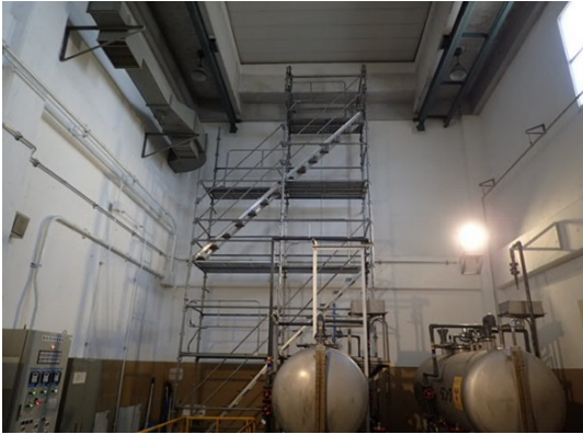
施設全景（施工前）
