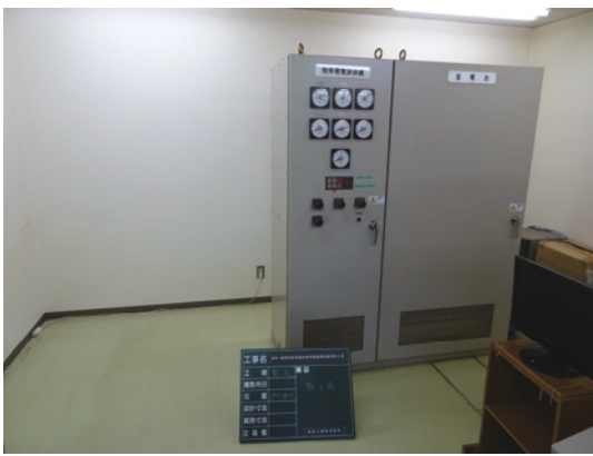
設備全景（施工前）
