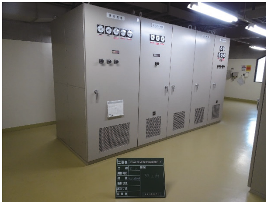
設備全景（施工前）
