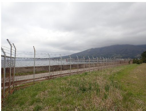
施設全景（施工前）
