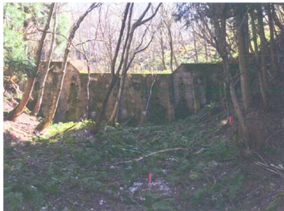
図 1.3.4-4 補強工事前の第 1 かん止堤
