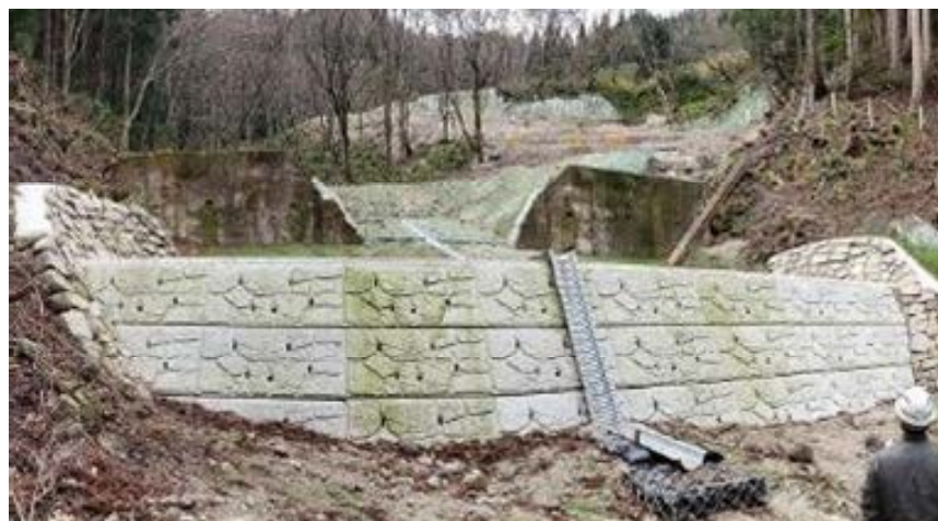
図 1.3.4-5 補強工事完了
