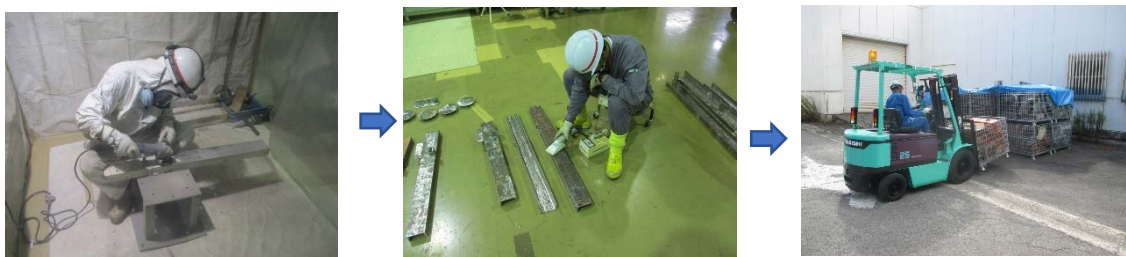
図 1.3.1-3 解体収納物の NR 対応
