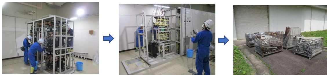
図 1.3.1-4 OP-2 高周波電源盤解体
