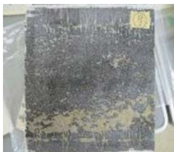
図5 ハンディ式レーザーによる平面部の塗膜分離状態
