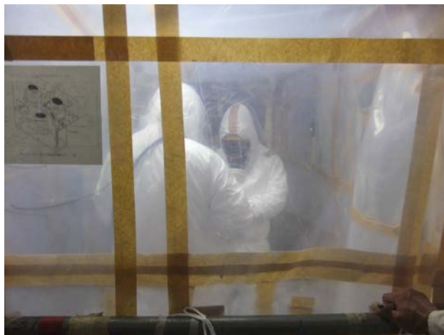
作業風景（サーベイ・脱装）
