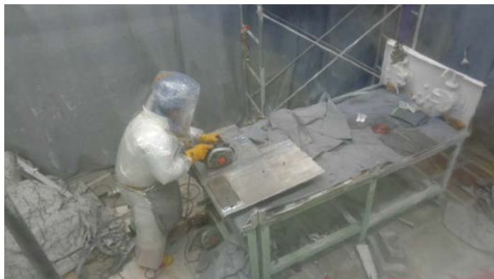
図 3.3.2-1 エアラインスーツによる GH-1 内解体作業風景
