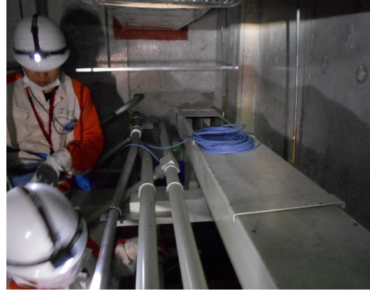
作業風景（制御ケーブル敷設）
