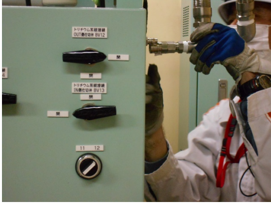
作業風景（配管つなぎ込み時）
