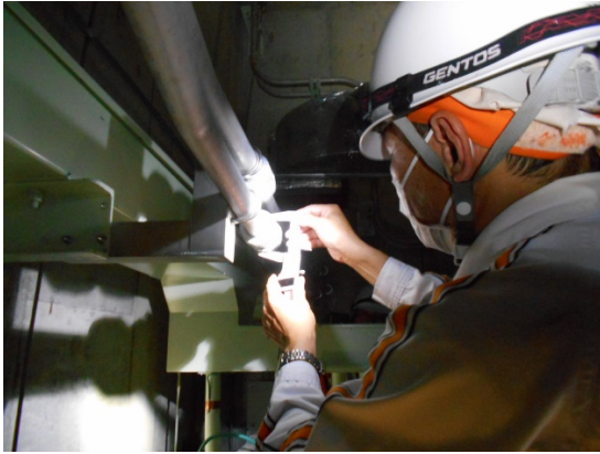
作業風景（配管敷設時）
