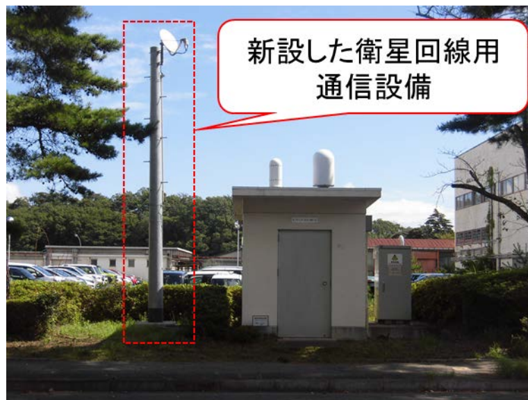
図 3.2.7 衛星回線用のアンテナ設備
