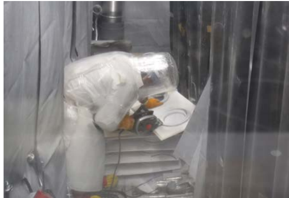
図 3.3.2-2 エアラインスーツによる GH-1 内での解体作業風景
