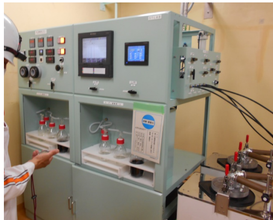
図 3.2.2-3 作業風景写真：第二付属排気筒トリチウム・カーボンサンプラの更新
