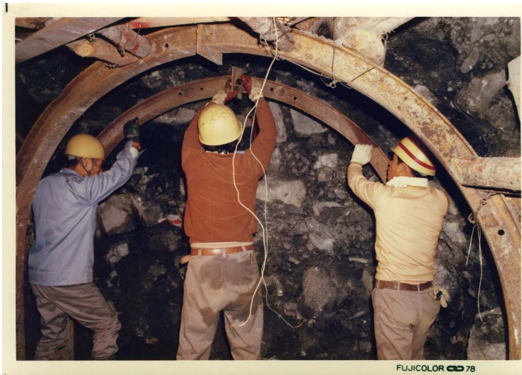
Photo.23 支保工の建て込み
