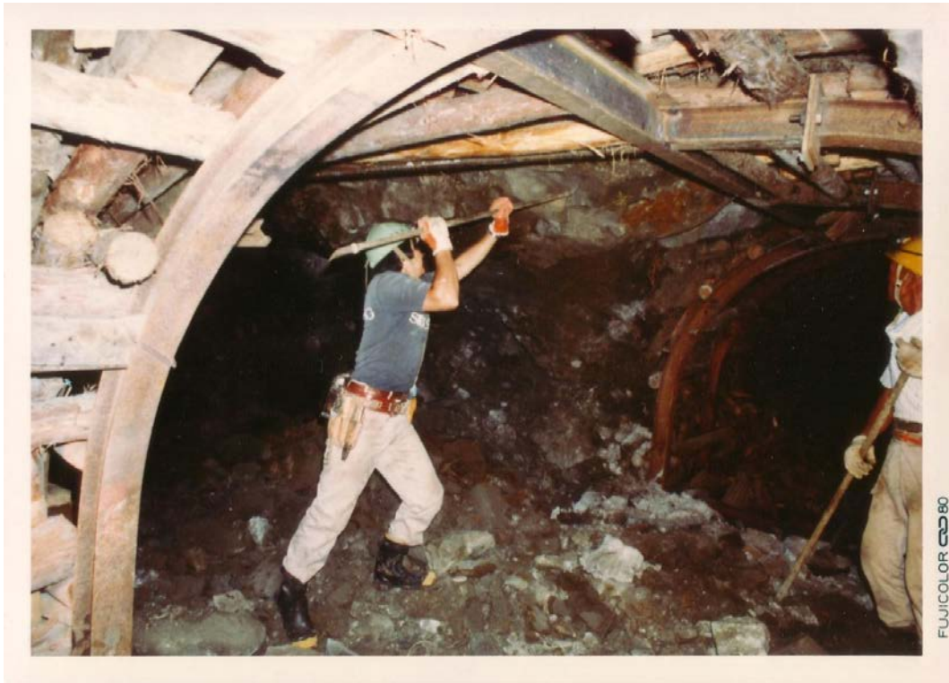
Photo.22 はつり (浮石の除去)
