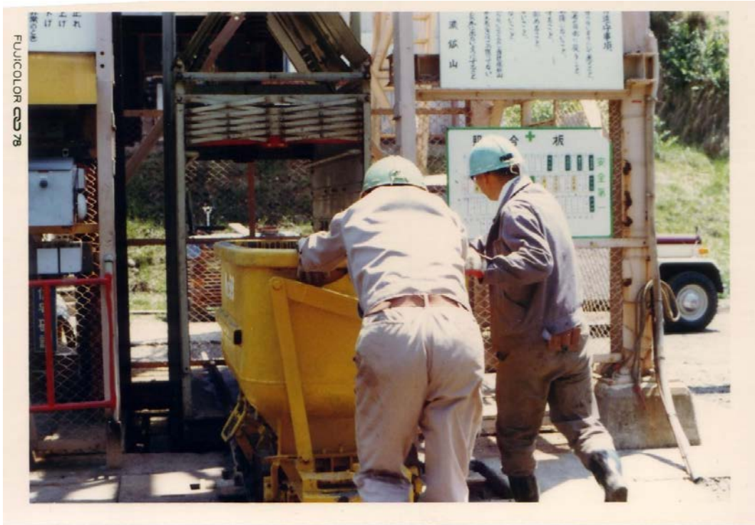
Photo.19 立坑ケージへの鉋車搬入
