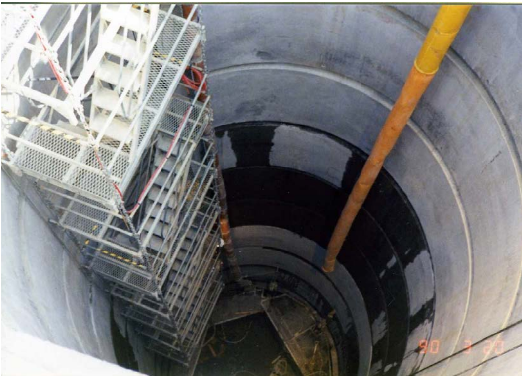
Photo.25 第2立坑坑口部掘削（やぐら設置前。左手は昇降用階段。）
