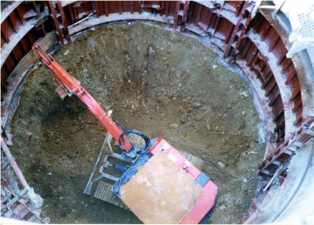
Photo.24 第2立坑坑口部掘削
