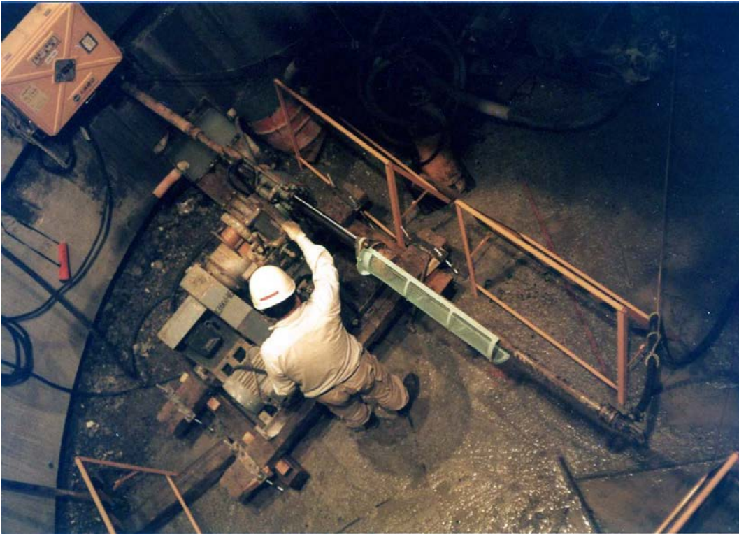
Photo.41 第2立坑底でのボーリング調査
