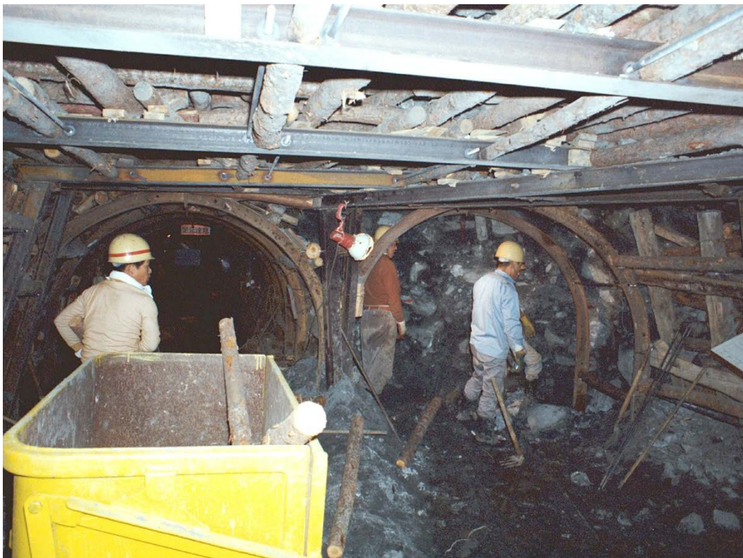
Photo.20 坑道掘削の様子
