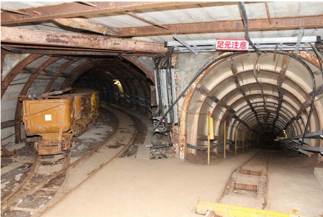
Photo.14 斜坑（右手が斜坑。左手に行くと本延坑道。鉱車が置かれている。）
