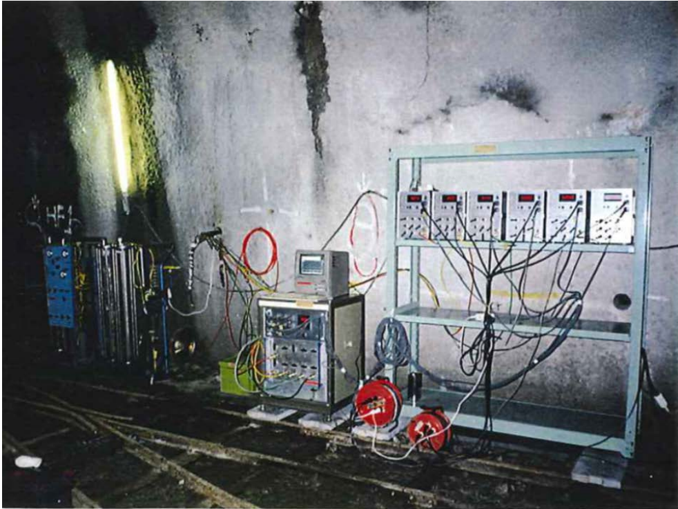
(a) 測定部 81) (第2立坑第1計測坑道)
