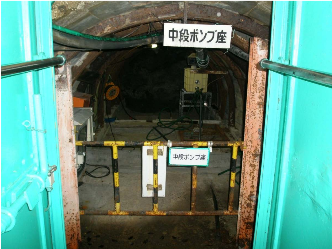
Photo.7 調査立坑・中段ポンプ座
