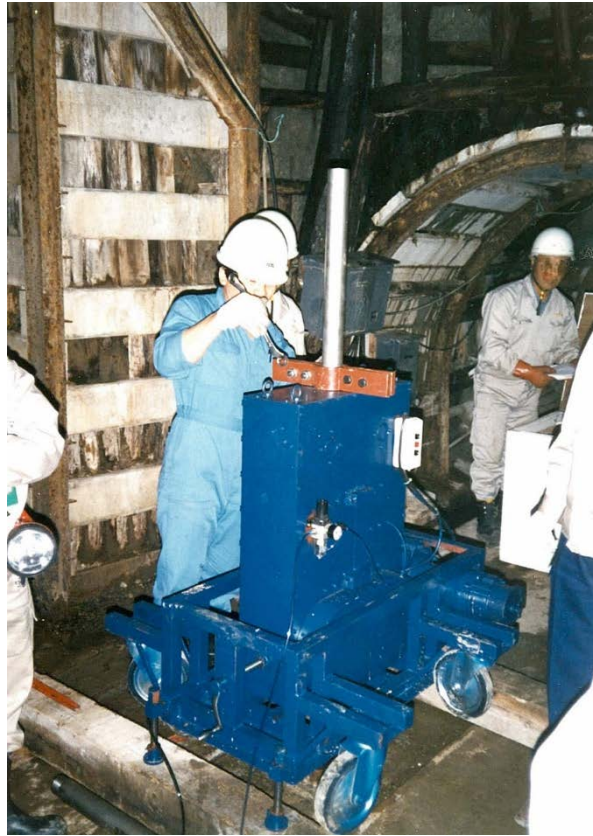
Photo.37 坑内採水作業（準備作業中）
