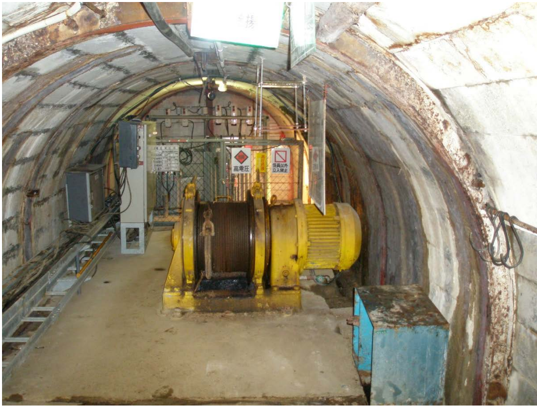
Photo.15 斜坑巻上機（奥に見えているのは第2変電設備）
