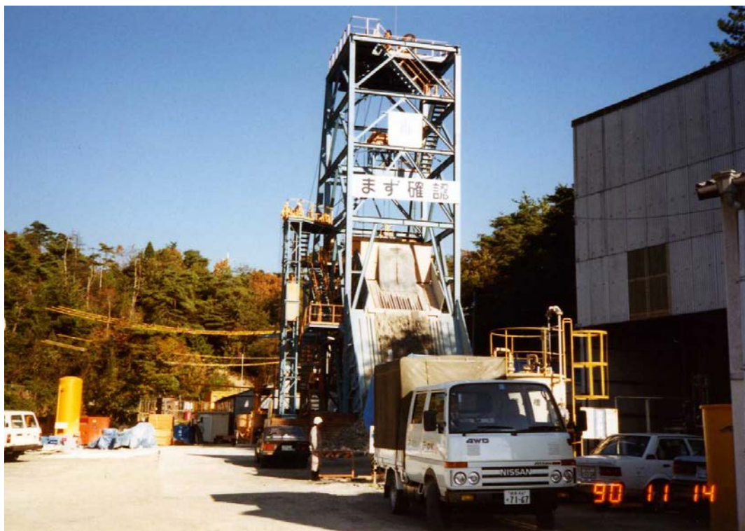
Photo.26 第2立坑掘削工事やぐら（1990年11月14日の日付）
