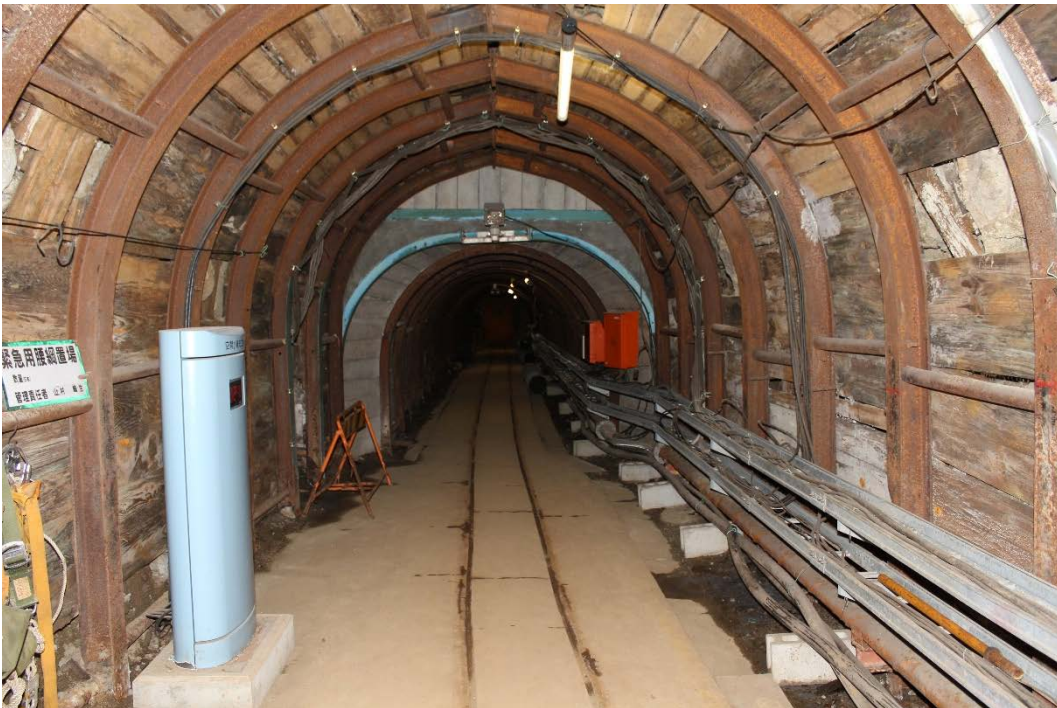
Photo.10 上盤連絡坑道
