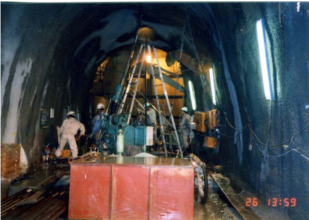
Photo.42 第2立坑第1計測坑道でのボーリング調査
