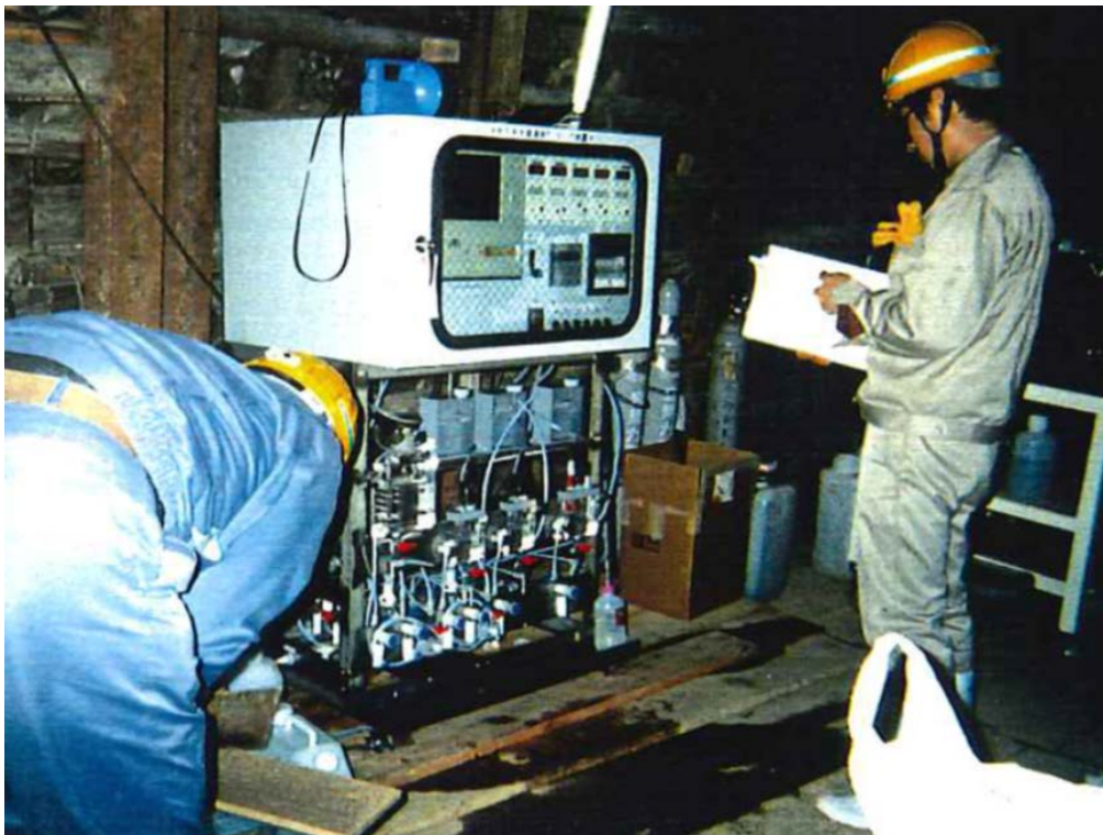
Photo.38 地下水水質連続モニタリング装置 108)
