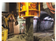
・キブルを地上から立坑坑底へ運搬
