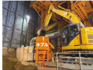
地上作業 ・埋め戻し材をキブル(運搬容器)へ投入 ・キブルを地上から立坑坑底へ橋、巻上機設備を用いて運搬
