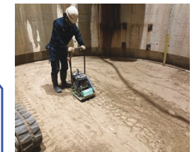
・バックホウにより埋め戻し ・振動コンパクターにより締め固め
