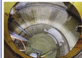
換気立坑の埋め戻し作業 ・深度90m付近(直径4.5m)
