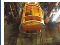
・キブルを地上から立坑坑底へ運搬
