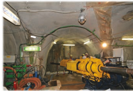
深度300m研究アクセス坑道でのボーリング調査
