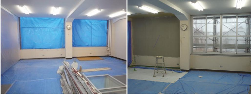
写真 7.1 開口閉塞工事状況
