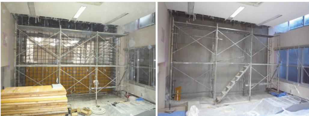
写真 7.3 耐震壁増設状況
