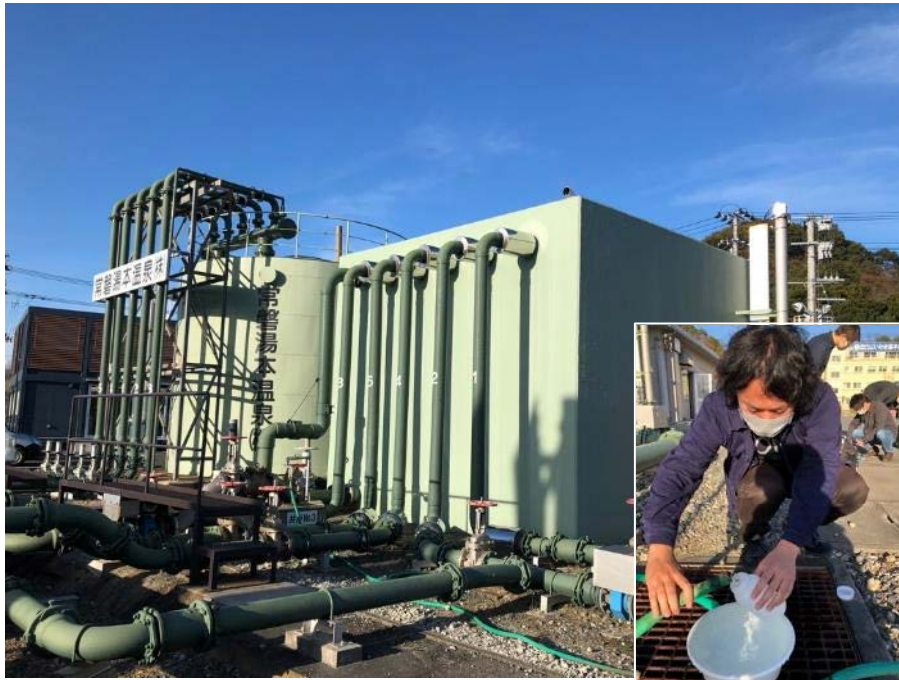
図 3.4.2-3 いわき市常磐湯本温泉でのサンプリング状況の写真
