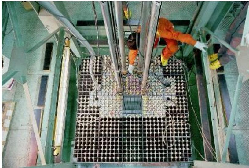
図 3.3.2 KUCA 固体減速炉心 (B 架台)
