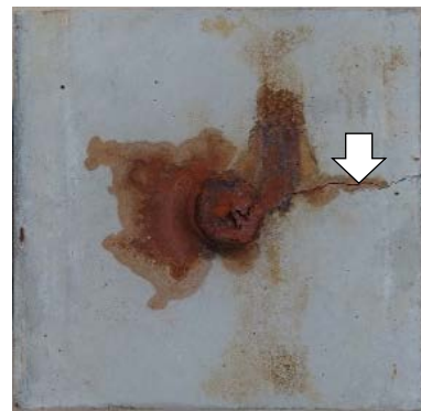
腐食① ひび割れ幅 0.2 mm
