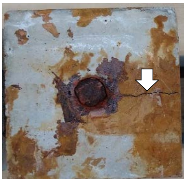
腐食② ひび割れ幅 0.5 mm
