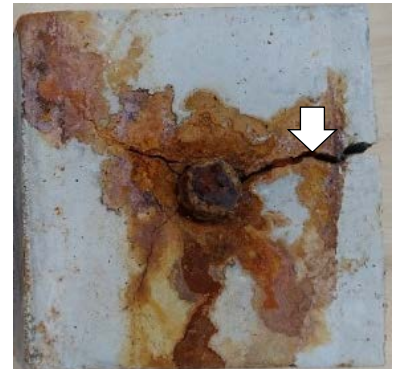
腐食④ ひび割れ幅 1.5 mm
