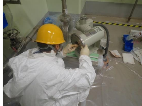
写真 1.7 処理済水ポンプ組立状況 （インペラ取付）
