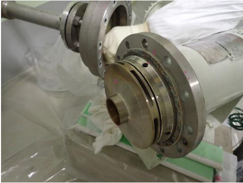
写真 1.6 処理済水ポンプ分解状況 （合マーク施工状況）
