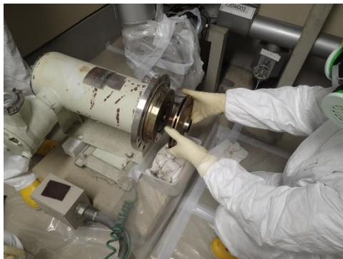
写真 1.4 モニタポンプ分解状況 （インペラ取り外し）
