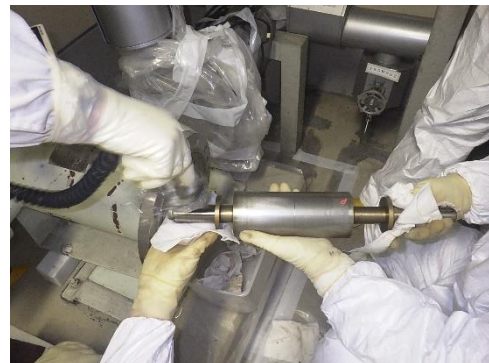
写真 1.5 モニタポンプ分解状況 （シャフト抜き出し）
