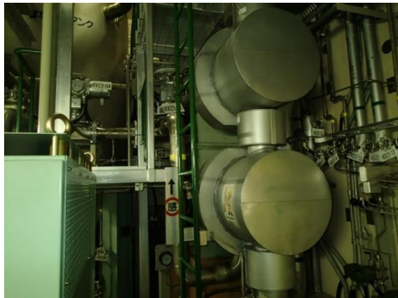
写真 2.1.8 重水熱交換器
