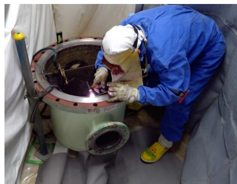
写真 2.1.10 水室の溶接補修
