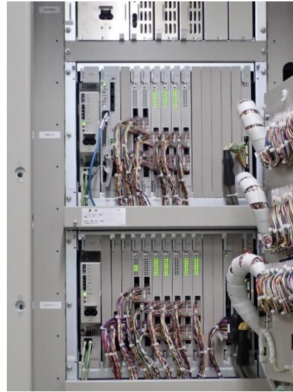
写真 2.1.4 スクラム特性試験回路盤更新後
