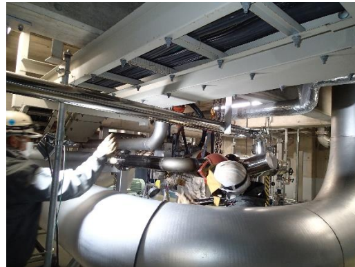
写真 2.1.18 冷却塔ポンド供給配管更新状況
