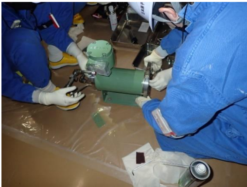
写真 2.1.11 ポンプの分解作業
