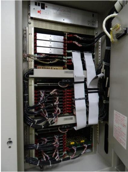
写真 2.1.3 スクラム特性試験回路盤更新前
