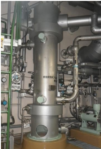
写真 2.1.7 使用済燃料プール水熱交換器
