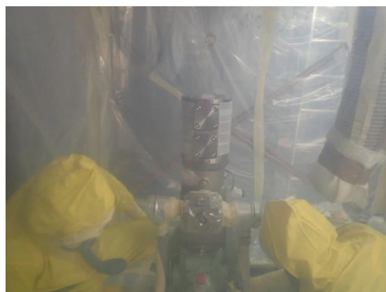
写真 2.1.15 ヘリウム圧縮機分解点検の様子
