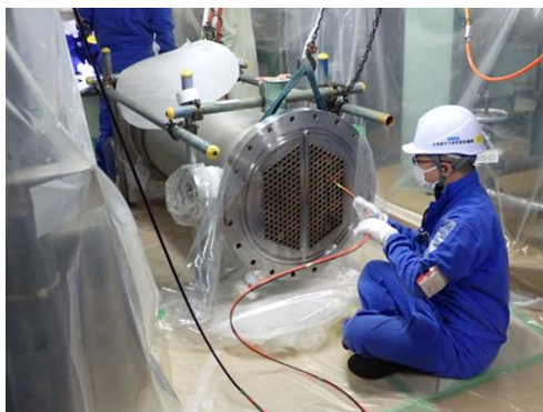
写真 2.1.9 伝熱管の過流探傷試験
