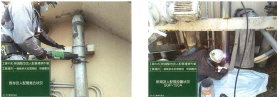
写真 4.2-2 補修作業中（左：既設配管切断、右：新設配管溶接）
