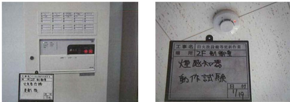
写真 4.4-6 更新状況（左：火災受信機（更新後）・右：煙感知器（更新後））
