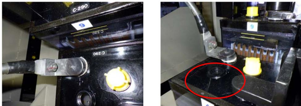
写真 4.5-4 蓄電池のひび割れ、端子の傾き
