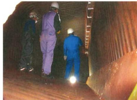
写真 4.4-1 性能検査の様子（左：水ドラム外観検査、右：燃焼室外観検査）
