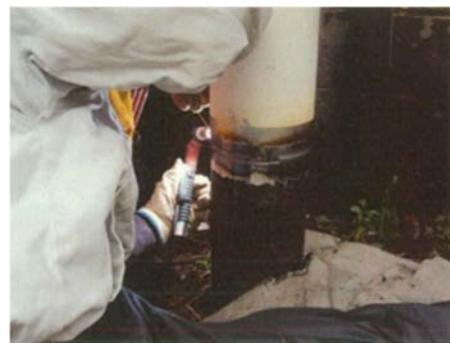
写真 4.2-1 補修作業中（左：既設配管撤去・右：新設配管溶接）
