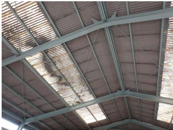
写真 5.1-6 屋根水平ブレース
