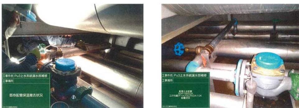
写真 4.1-1 配管更新(左：既設・右：新設)
