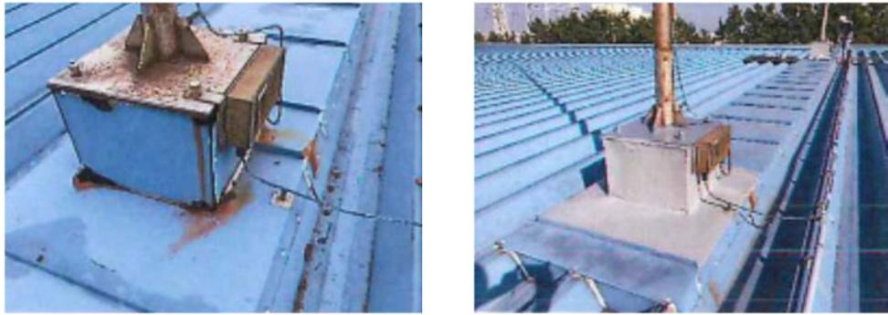
写真 4.4-5 避雷針基礎（左：補修前・右：補修後）
