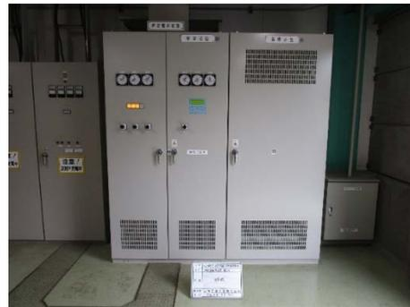
写真 4.5-1 直流電源装置 (左：既設、右：新設)
