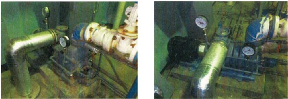
写真 4.3-1 冷却水ポンプ（左：更新前・右：更新後）
