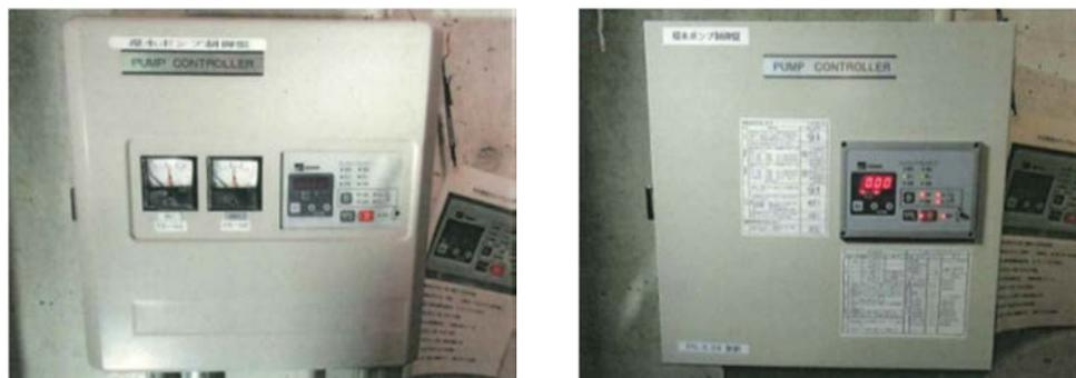
写真 4.4-8 還水ポンプ制御盤（左：更新前・右：更新後）
