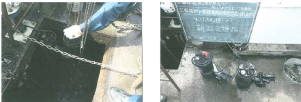
写真 4.2-3 更新作業中（左：既設ポンプ引き上げ、右：新旧交換品）
