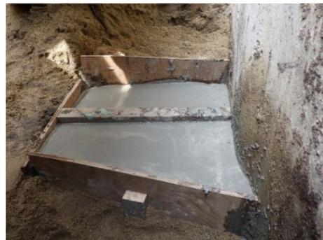
写真 4.1-3 漏水箇所復旧作業(左：止水パテ・右：早強モルタル)
