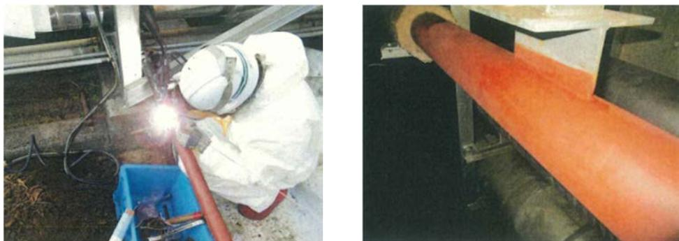
写真 4.4-4 補修状況（左：還水配管補修状況・右：還水配管補修完了後）
