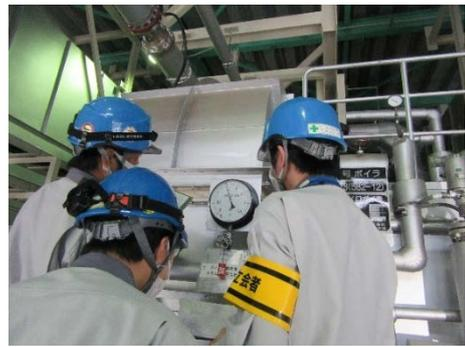
写真 4.4-2 施設定期自主検査状況（左：検査前条件確認、右：運転圧力確認）
