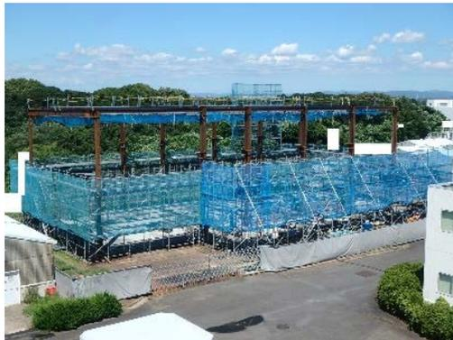
写真 6.1-1 第三ウラン貯蔵庫 鉄骨建方状況 令和4年7月
