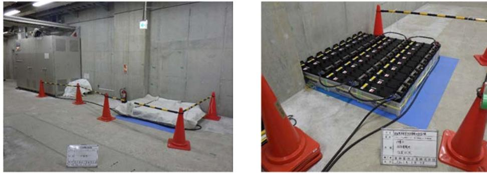
写真 4.5-5 仮設蓄電池の設置状況
