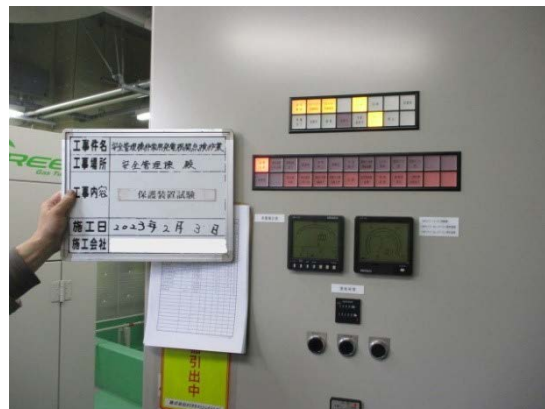
写真 2.2.13-2 保護装置試験
