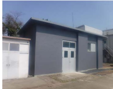
写真 2.11.6-2 耐震壁 施工後
