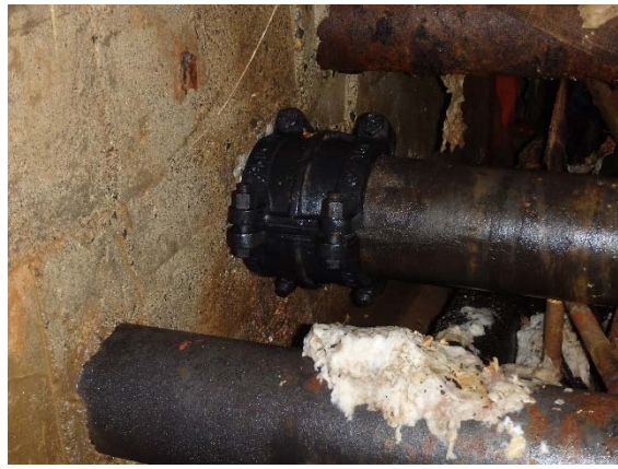
写真 2. 2. 19-3 工水配管の仮補修状況(壁取合部)
