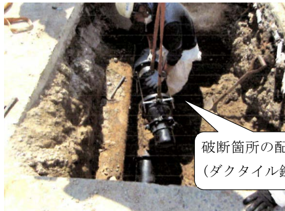
写真 2. 2. 19-4 工水配管更新工事の状況
