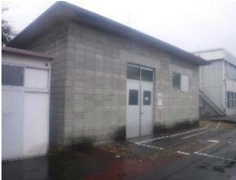
写真 2.11.6-1 耐震壁 施工前
