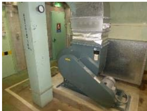
写真 2.2.2-3 給気第4系統 改修後
