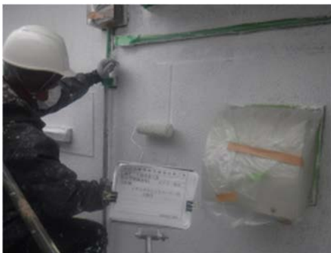
写真 2.11.6-3 外壁塗装改修 施工状況
