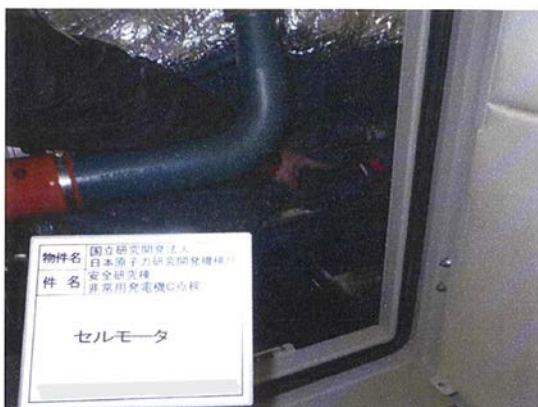
写真 2.2.15-1 セルモータ点検
