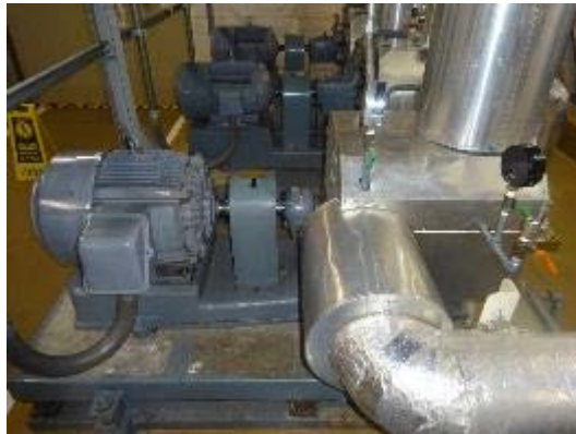
写真 2.2.4-1 軸受交換後のポンプ及び電動機外観
