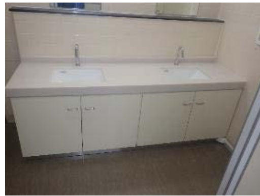
写真 2.11.8-4 洗面器水栓 更新後
