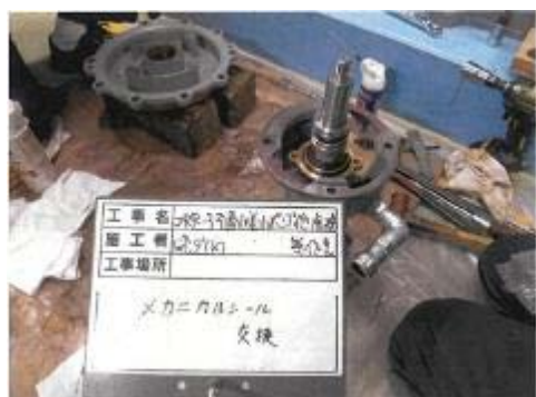
写真 2.2.1-3 メカニカルシール交換
