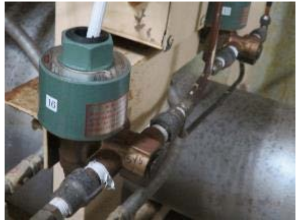
写真 2.2.5-2 電磁弁② 更新前
