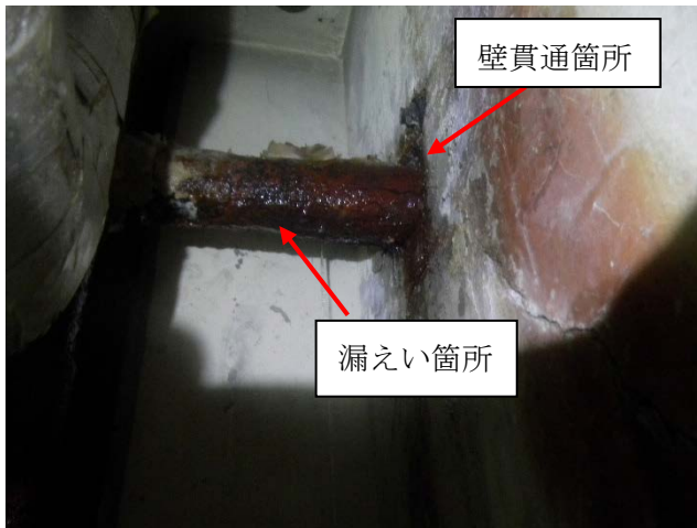
写真 2. 2. 16-1 蒸気環水管 修理前
