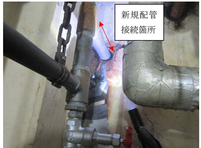
写真 2. 2. 16-2 蒸気環水管 修理後
