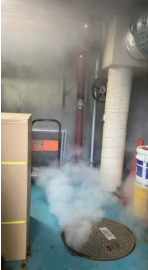
写真 2. 2. 19-1 蒸気の噴出状況
