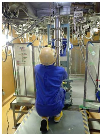
写真 2.1.2 管外駆動部取外し
