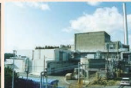
解体中の原子力施設
