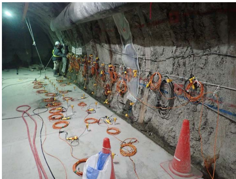
図 18 試験坑道6における弾性波トモグラフィの実施状況
