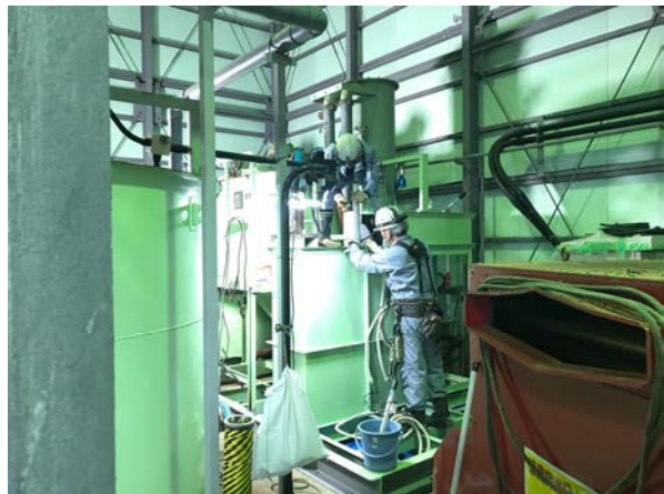
(b) 濁水処理設備の更新
