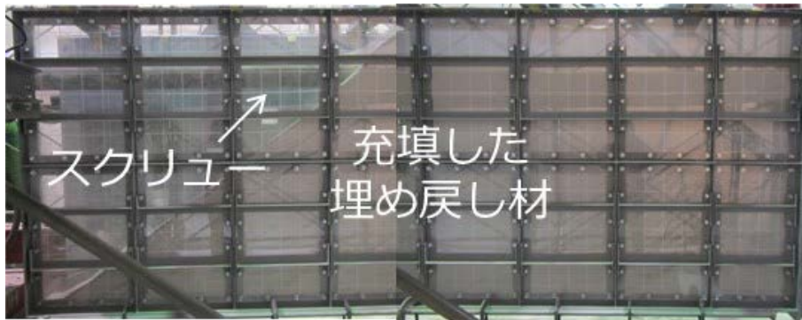
図 48 スクリュー工法による埋め戻し材の充填後の外観
