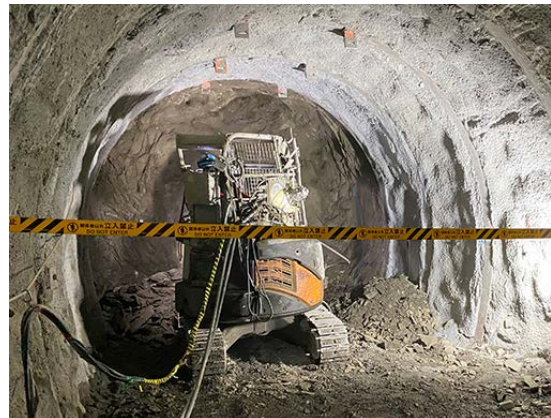
(b) 掘削の様子
