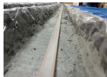
(c) フィーダー線の敷設状況
