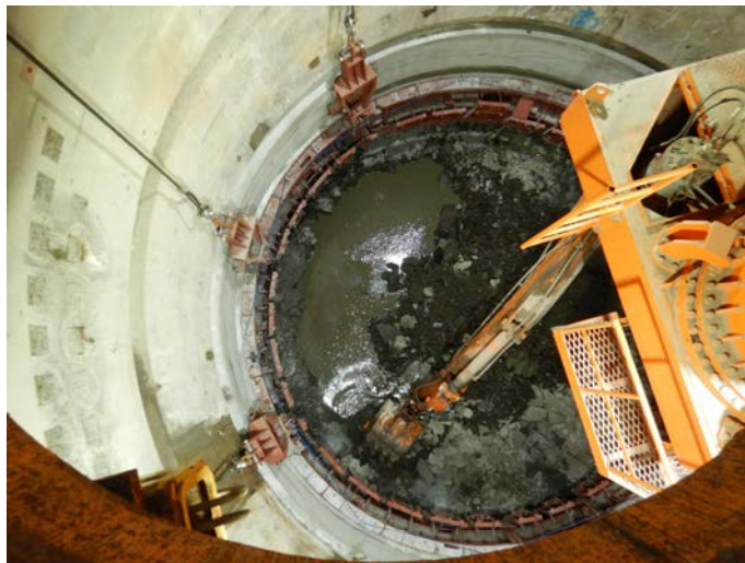
図 78 東立坑の掘削状況
