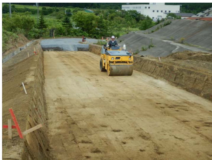
図 81 掘削土（ズリ）置場搬入用道路の造成工事の様子
