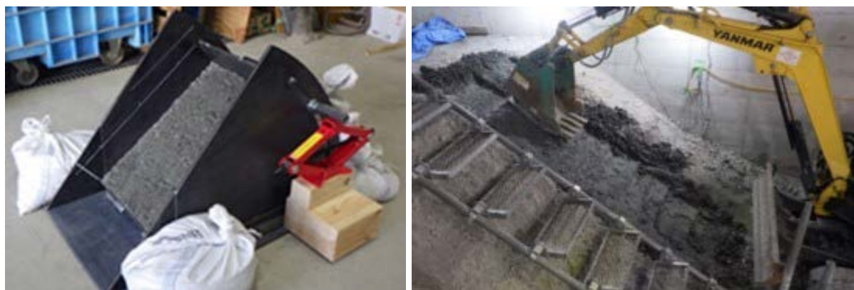
(a) 斜め撒き出し試験 (b) 施工試験
