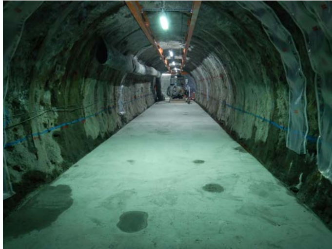
図 77 350m 調査坑道整備完了状況（試験坑道 6）
