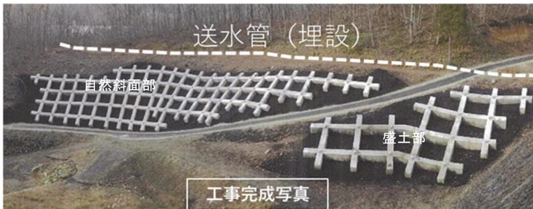
図7 鉦さいたい積場の右岸側斜面の地震対策工事
