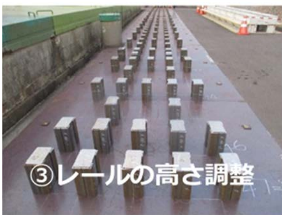
図IV-3-6 上屋移動用レール敷設作業の写真
