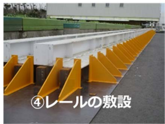
図IV-3-6 上屋移動用レール敷設作業の写真
